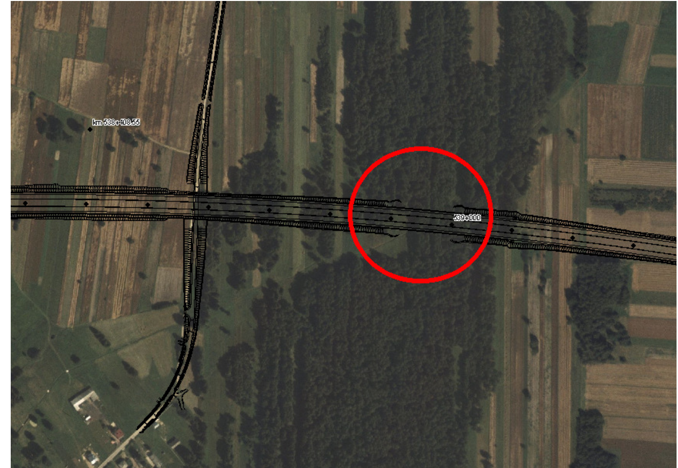
rys. 27 Lokalizacja przejścia dla zwierząt km 538+950
