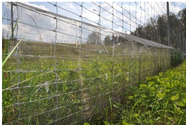
Zdjęcie 7. Sposób zamontowania siatki chroniącej płazy na zwykłej siatce ogrodzeniowej.
