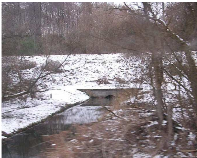
Zdjęcie 6. Przepust drogowy prowadzący Kanał Wieliszewski.
