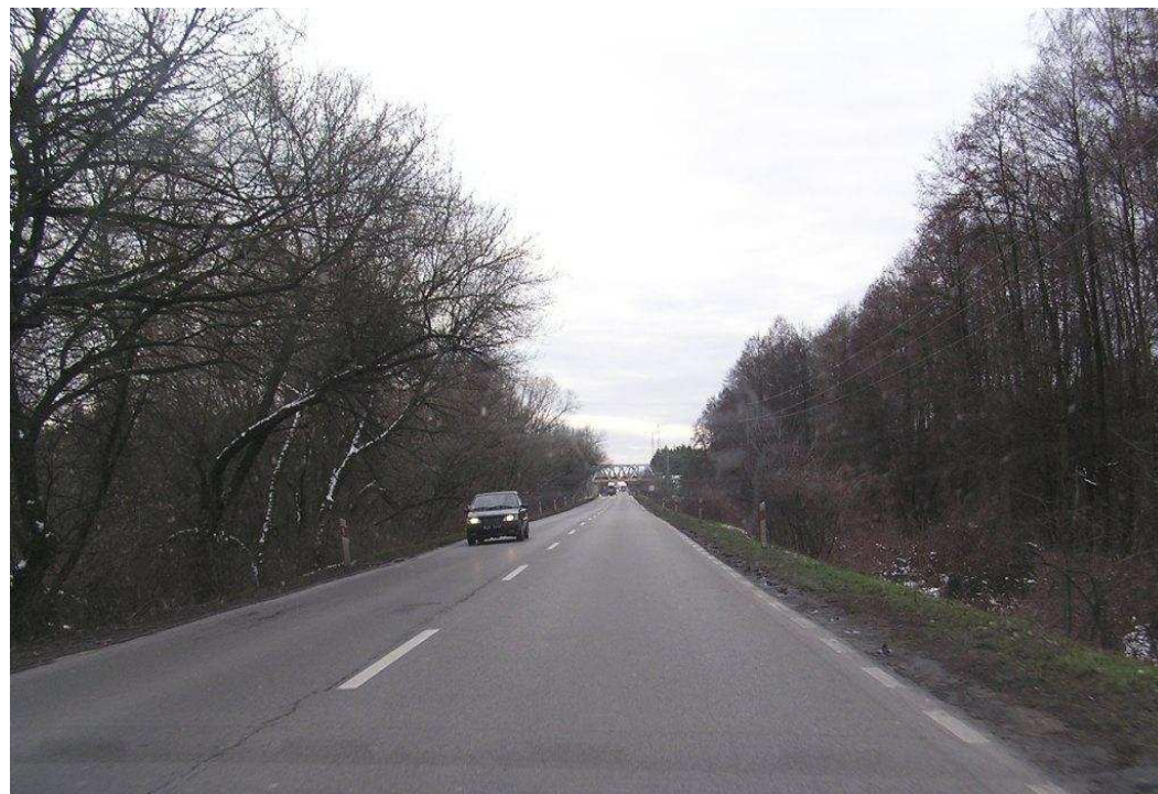
Zdjęcie 2. Droga krajowa nr 61 – przecięcie lasu pomiędzy Michałowem – Reginowem a Nieporętem, widoczny wiadukt kolejowy nad drogą.
