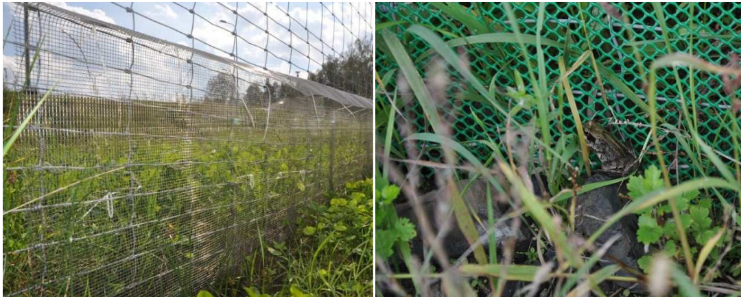
Zdjęcie 2. Sposób zamontowania siatki chroniącej płazy na zwykłej siatce ogrodzeniowej.
