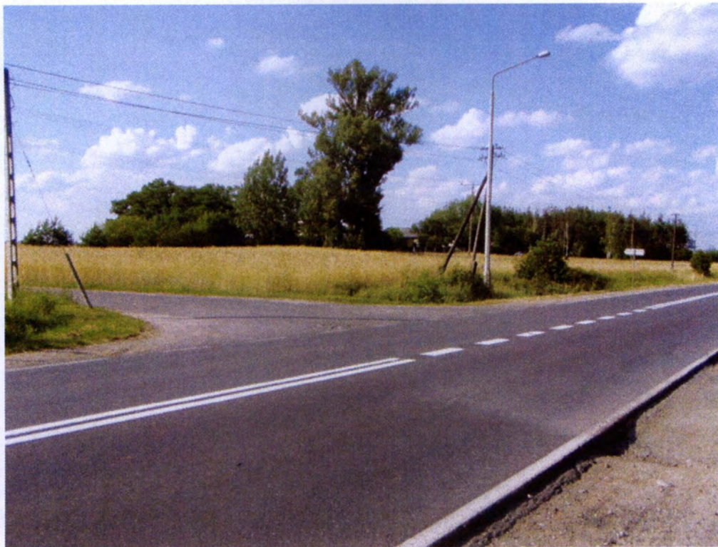
Fot. 1 Skrzyżowanie drogi krajowej nr 61 z drogą powiatową nr 01108
