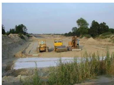
fot. Piotr Sereczyński Faza realizacji inwestycji.
