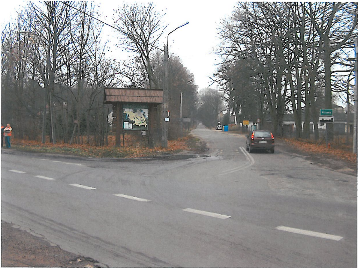
Fot 3. Okolice miejscowości Pilawa w km około 16+300
