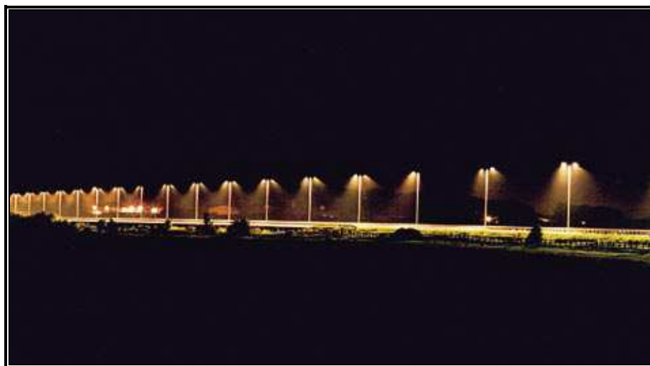
Fot. 10.2 Przykład wykonania oświetlenia drogi przy wykorzystaniu lamp o ukierunkowanym strumieniu światła minimalizującego wabienie owadów i nietoperzy [169]
