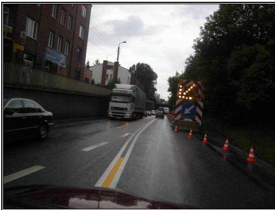
Fot. 7.20 Prace remontowe nawierzchni drogi krajowej nr 50 oraz zwężenie, ciągnące się aż pod wiadukt w centrum miasta. Takie sytuacje wywołane są ruchem ciężkich pojazdów, które niszczą nawierzchnię o wiele szybciej niż samochody osobowe. Zwężenia mogą również być przyczyną wielu kolizji. Widoczna na zdjęciu ciężarówka porusza się zwężonym pasem z bardzo małym zapasem miejsca po obydwu stronach.
