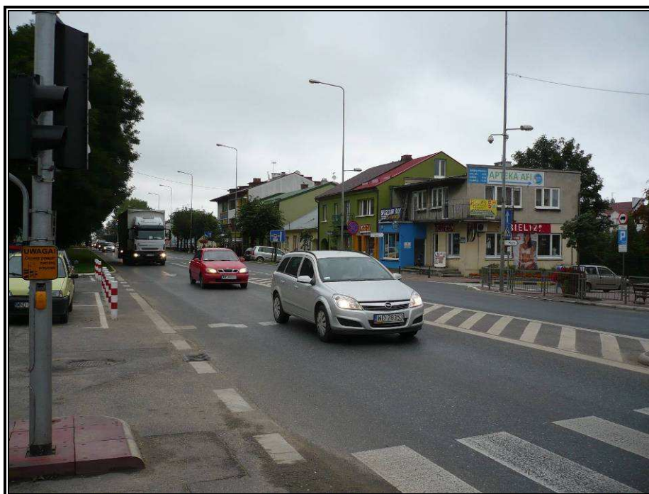
Fot. 7.10 Droga krajowa nr 61 w centrum Serocka w kierunku Augustowa. Droga na całej długości przejścia przez miasto ma tylko jeden pas w każdą stronę co przy nasilonym ruchu samochodów ciężarowych jest wysoce uciążliwe.
