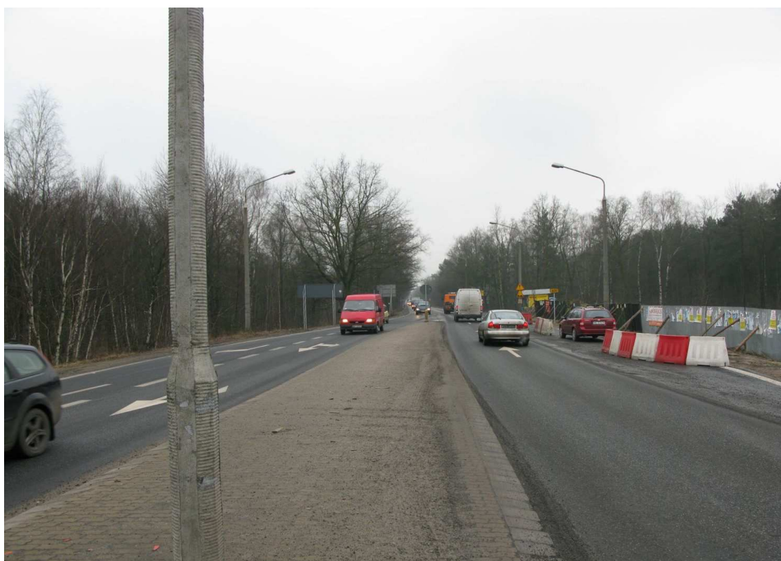
Fot. 2 Widok na DW 631 od ronda
