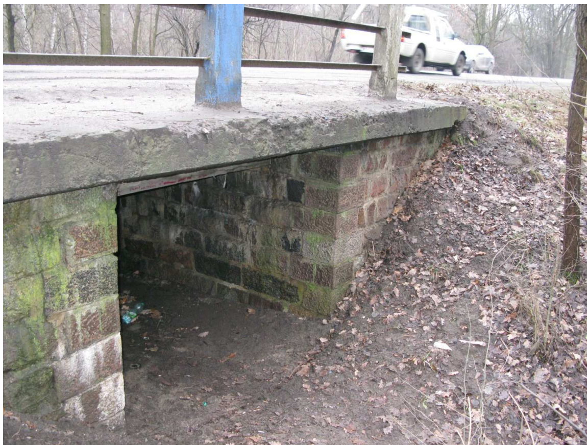
Fot. 3 Widok na przepust od strony zachodniej
