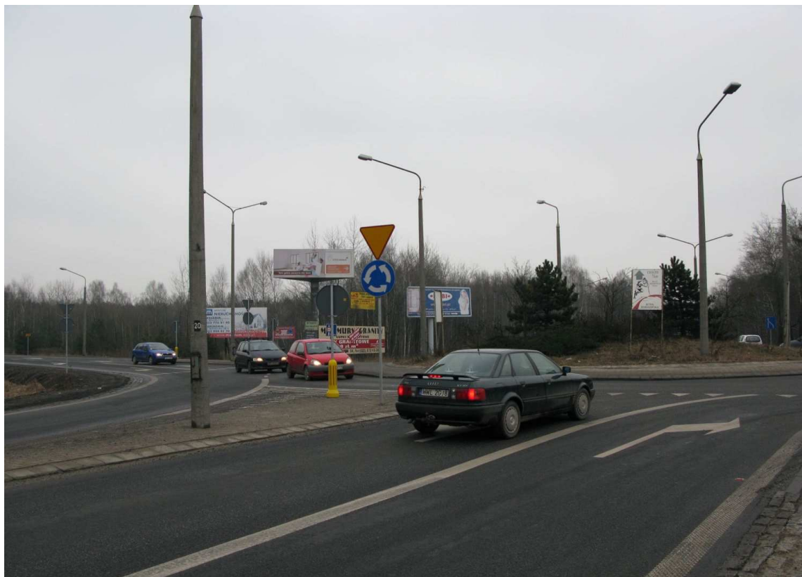
Fot. 1 Widok na rondo 631/634
