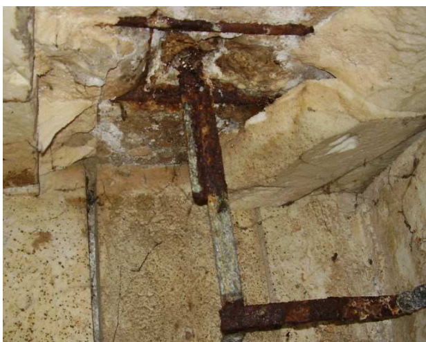
Fot. 28 Wzmoczona korozja spowodowana przeciekaniem wody w miejscu przebicia płyty (z lewej), cały spód konstrukcji obłożony szkłem piankowym jako formą szalunku (z prawej)
