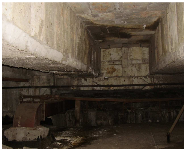
Fot. 39 Odkryte zbrojenie oraz intensywne przecieki na poprzecznicy oraz spodzie płyty w sąsiedztwie dźwigara mostu nad elektrownią (od strony górnej wody)
