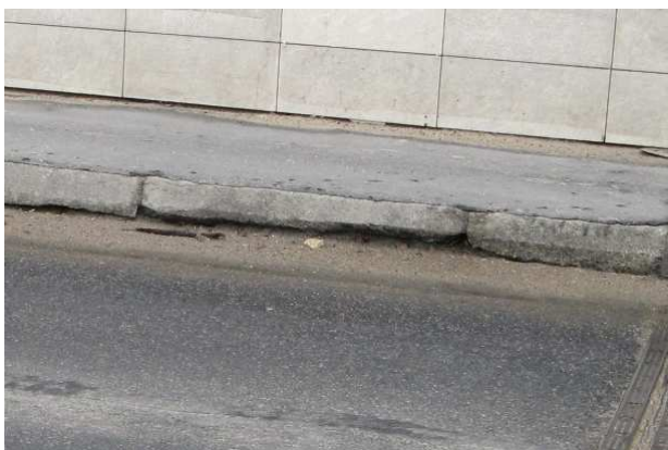
Fot. 9 Całkowicie niedrożny wpust w prześle nr 5 (z lewej) oraz przykład częściowego zanieczyszczenia (z prawej)
