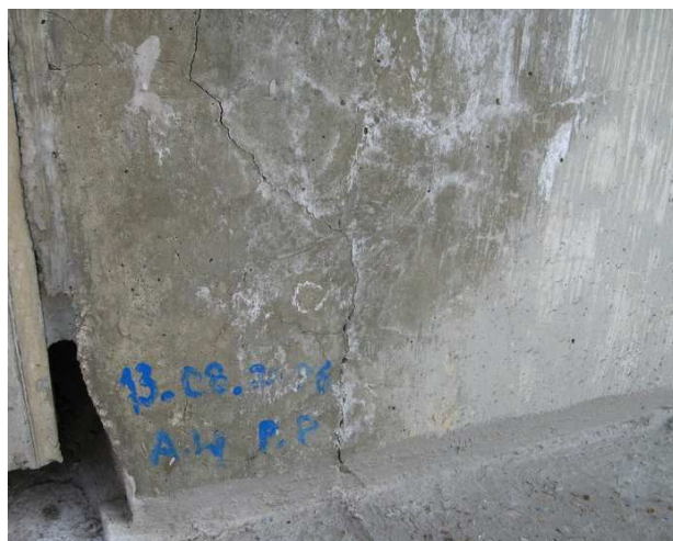
Fot. 58 Spękania kompensatorów. Szczelina ~ 10mm w osi podpory 4 oraz liczne pęknięcia (do 0,2mm) w betonowym bloku w osi podpory 1
