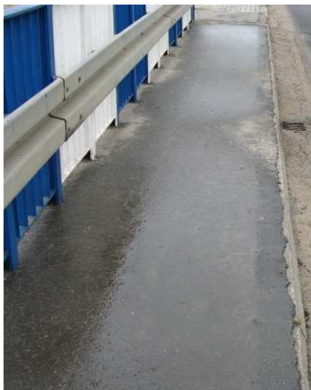
Fot. 11 Zastoiska wody spowodowane niewielkimi spadkami poprzecznymi chodników, piasek zalegający wzdłuż krawężników, most na budynku elektrowni (z lewej) oraz nad jazem (z prawej)
