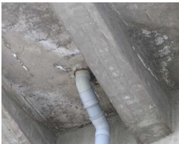
Fot. 30 Lokalnie wykwit na spodzie płyty oraz intensywne krystaliczne zacieki na żebrach wspornika
