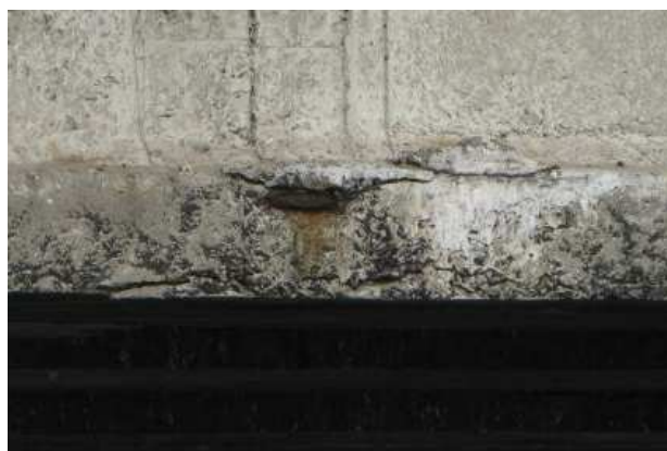
Fot. 20 Ubytek betonu i korodujące zbrojenie przęsło 4 DW, odspajanie otuliny, korozja pętli zbrojenia poprzeczniczy przęsło 4 GW
