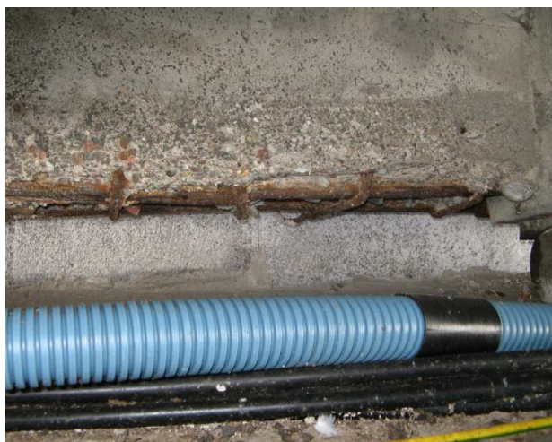
Fot. 55 Stwierdzono liczne przypadki ubytków betonu lub niedobetonowania poprzecznic a także korozję odsłoniętego zbrojenia
