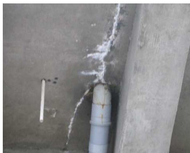
Fot. 31 Lokalnie widoczne pęknięcia na spodzie płyty oraz w gzymsie
