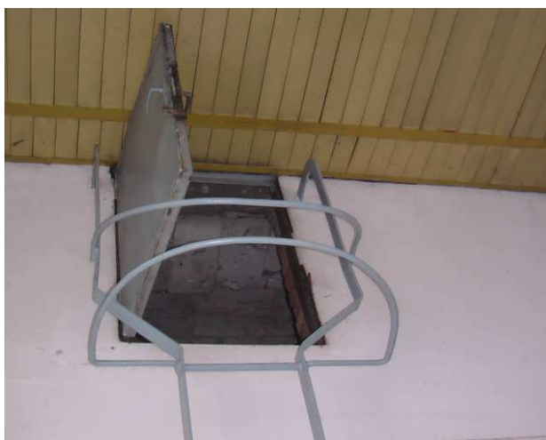
Fot. 29 Włazy pod obiekt na budynku elektrowni, brak dostępu do spodu konstrukcji w budynku elektrowni (z lewej)
