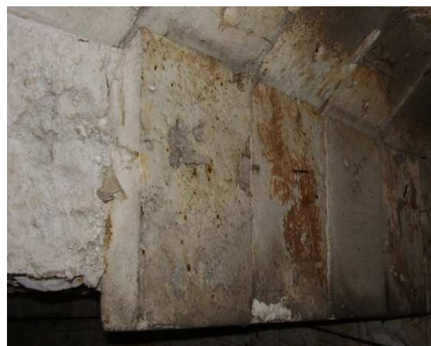
Fot. 28 Wzmoczona korozja spowodowana przeciekaniem wody w miejscu przebicia płyty (z lewej), cały spód konstrukcji obłożony szkłem piankowym jako formą szalunku (z prawej)
