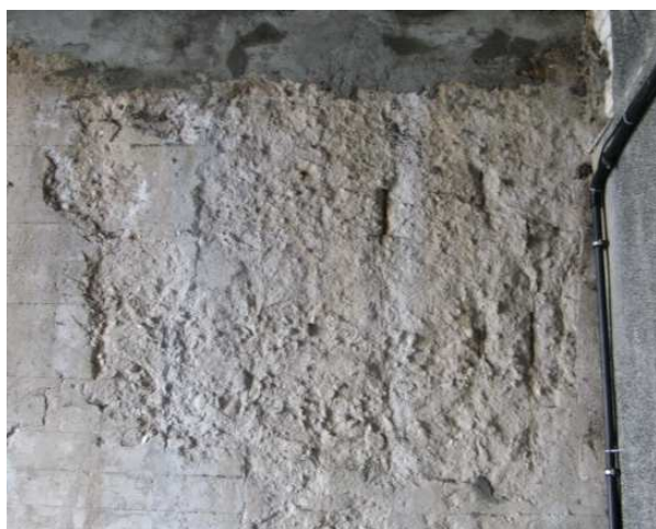
Fot. 33 Degradacja oraz ubytki betonu podpory w osi 1
