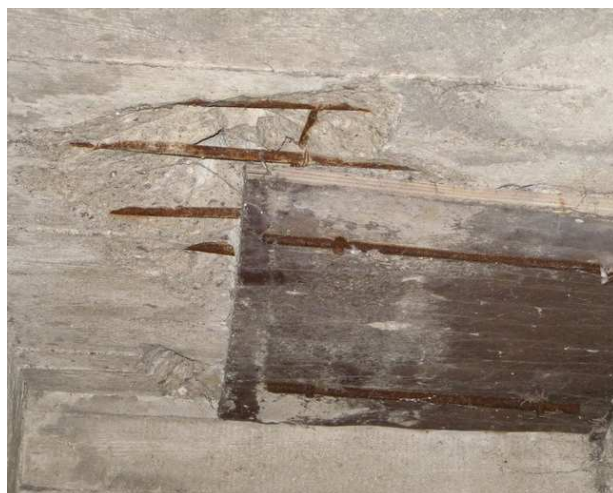
Fot. 44 Przykłady licznie występujących ubytków betonu i korozji odsłoniętego zbrojenia na spodzie płyty oraz sporadycznie pozostawionych elementów szalunku
