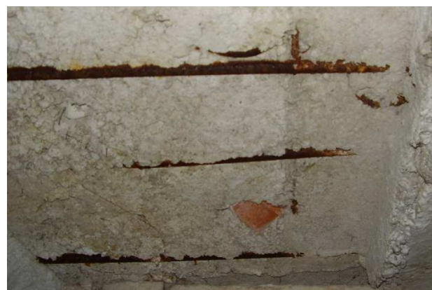
Fot. 26 Korozja niebetonowanych prętów zbrojenia płyty pomostu obiektu na budynku elektrowni
