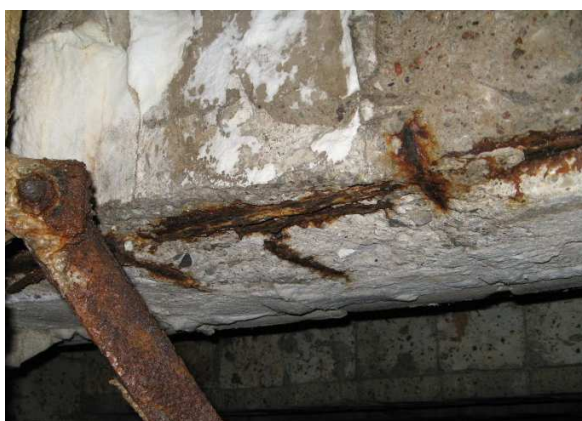
Fot. 24 Ubytki betonu oraz korozja odsłoniętego zbrojenia poprzecznicy kolejno od strony GW oraz w środku rozpiętości
