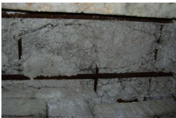
Fot. 26 Korozja niebetonowanych prętów zbrojenia płyty pomostu obiektu na budynku elektrowni
