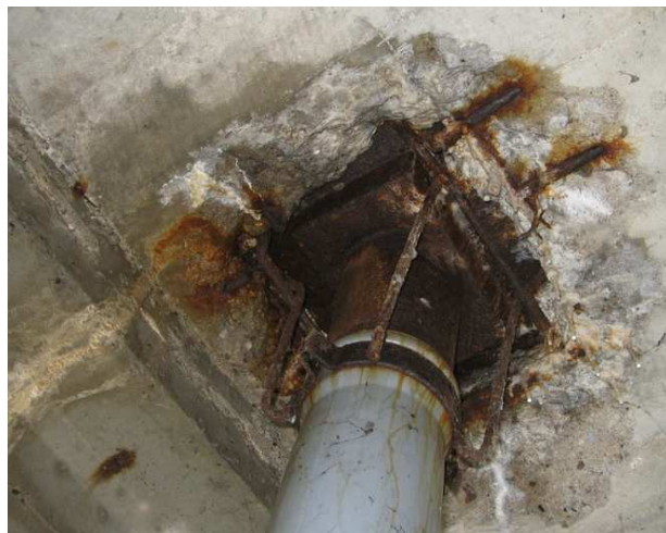
Fot. 43 Niewłaściwe osadzenie wpustów, ubytki betonu, zaawansowana korozja zbrojenia oraz widoczne przecieki wody i krystaliczne wykwity – opisane uszkodzenia występują wokół każdego wpustu
