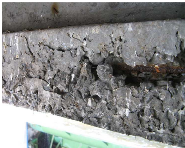
Fot. 50 Częste błędy wykonawcze – niedobetonowania oraz liczne raki w dźwigarach (lewe zdjęcie), a także rozwarstwienia półek dolnych już na etapie betonowania (prawe zdjęcie)
