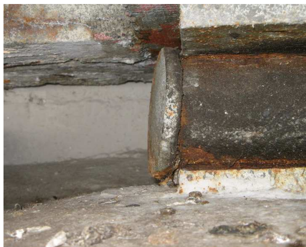
Fot. 60 Spękana ścianka zaplecza przyczółka od strony Nasielska (zdjęcie lewe) oraz oderwany kołnierz wałka łożyska w osi podpory 4 (strona prawa)
