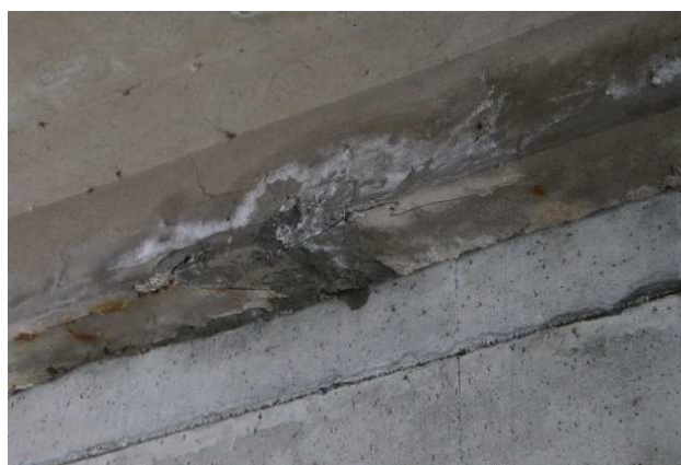
Fot. 25 Rysy oraz pęknięcia, a także zawilgocenie i wykwyty na skrajnej poprzecznicy mostu monolitycznego
