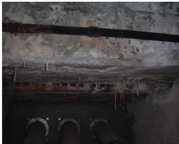
Fot. 38 Rura wychodząca przez okno budynku, krystaliczne stalaktyty pod belką mostu nad elektrownią (od strony górnej wody)
