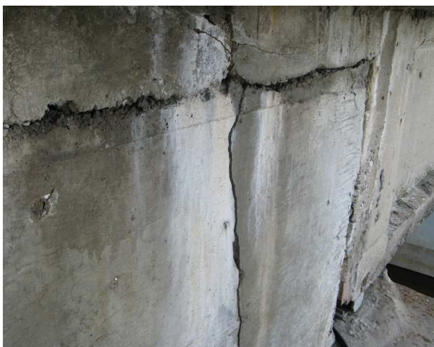
Fot. 58 Spękania kompensatorów. Szczelina ~ 10mm w osi podpory 4 oraz liczne pęknięcia (do 0,2mm) w betonowym bloku w osi podpory 1
