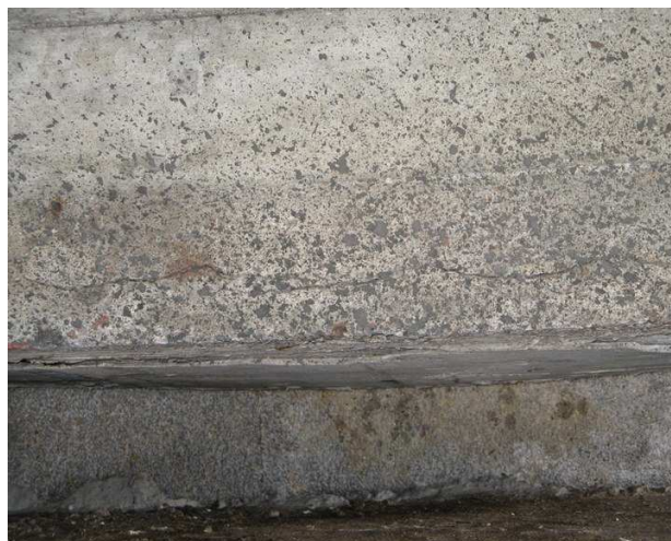
Fot. 56 Rysy oraz pęknięcia w dolnych partiach poprzecznie świadczące o korozji zbrojenia – występują na większości poprzecznic podporowych
