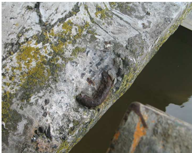
Fot. 49 Lokalnie występujące ubytki oraz spękania w półkach dolnych dźwigarów spowodowane korodującym zbrojeniem
