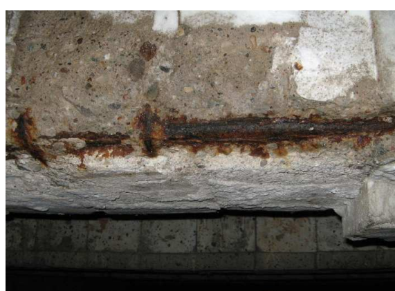
Fot. 24 Ubytki betonu oraz korozja odsłoniętego zbrojenia poprzecznicy kolejno od strony GW oraz w środku rozpiętości
