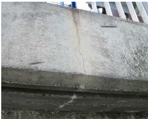
Fot. 59 Przykłady spękań gzymsów zlokalizowane na całej ich długości w rozstawach ~0,2 do 1,0m – głównie nad podporami
