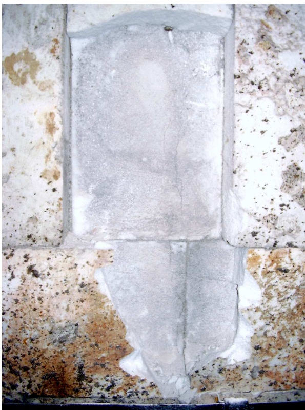
Fot. 22 Rysa pionowa w dźwigarze głównym na budynku elektrowni od strony górnej wody GW, dylatacja
