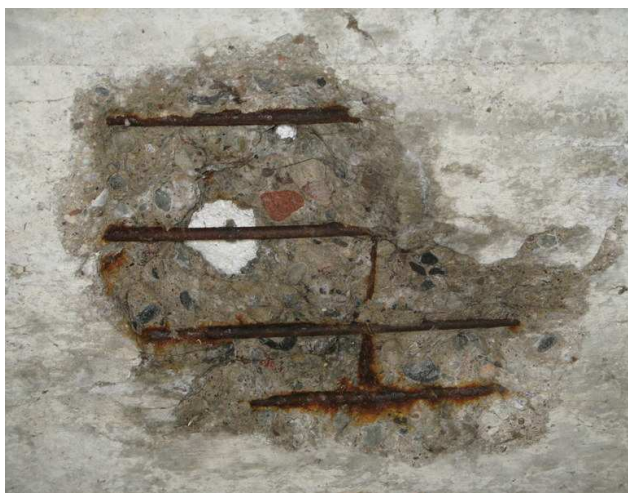
Fot. 44 Przykłady licznie występujących ubytków betonu i korozji odsłoniętego zbrojenia na spodzie płyty oraz sporadycznie pozostawionych elementów szalunku
