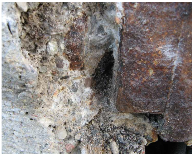
Fot. 57 Wzmoczona korozja większości zewnętrznych obetonowanych bloków kotwiących (z lewej), nieskorodowany nieobetonowany blok z prawej
