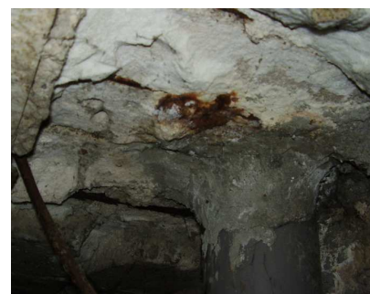
Fot. 27 Intensywne krystaliczne zacieki na w miejscach osadzenia rur spustowych
