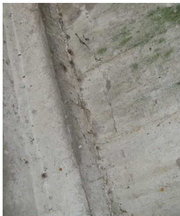
Fot. 46 Podłużne pęknięcia płyty pomostu występujące lokalnie w kilku polach
