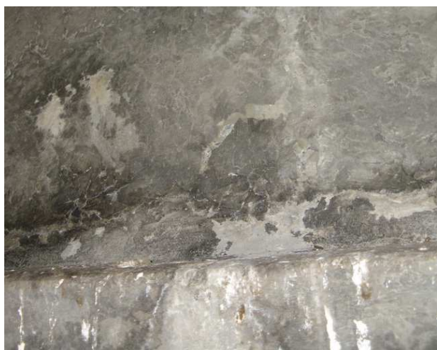
Fot. 51 Stwierdzone lokalnie niebezpieczne rozsegregowanie składników betonu – lico środka (z lewej), wyluskane kruszywo pozbawione spoiwa (z prawej)
