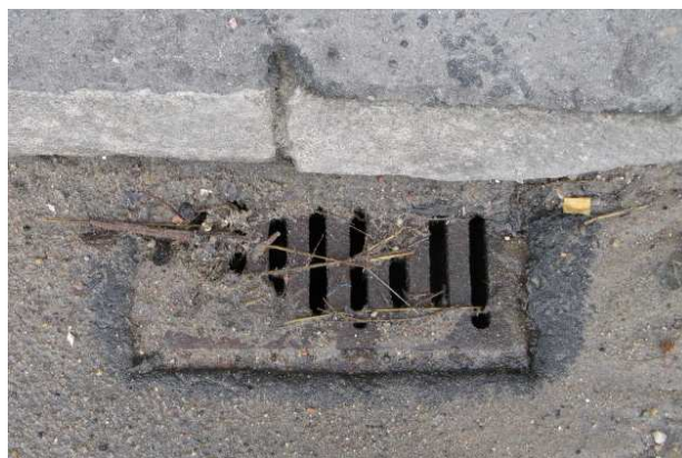
Fot. 9 Całkowicie niedrożny wpust w prześle nr 5 (z lewej) oraz przykład częściowego zanieczyszczenia (z prawej)
