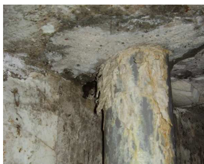
Fot. 27 Intensywne krystaliczne zacieki na w miejscach osadzenia rur spustowych
