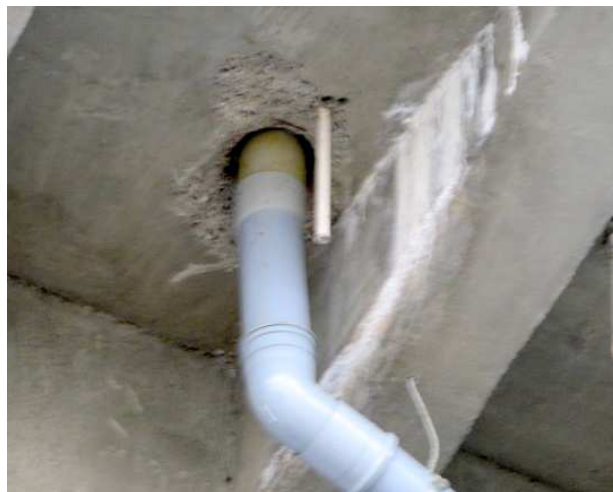
Fot. 32 Ubytki betonu przy dylatacji oraz wokół wpustu
