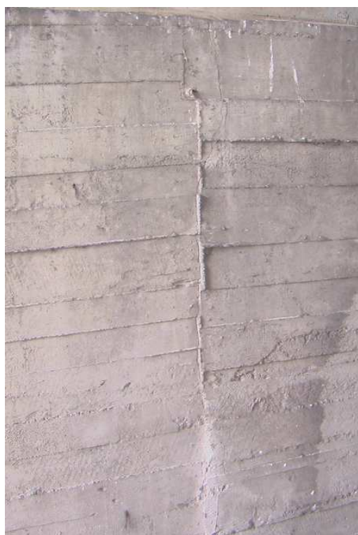
Fot. 34 Pęknięcie na całej wysokości podpory w osi 1
