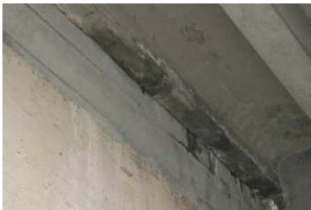
Fot. 25 Rysy oraz pęknięcia, a także zawilgocenie i wykwyty na skrajnej poprzecznicy mostu monolitycznego
