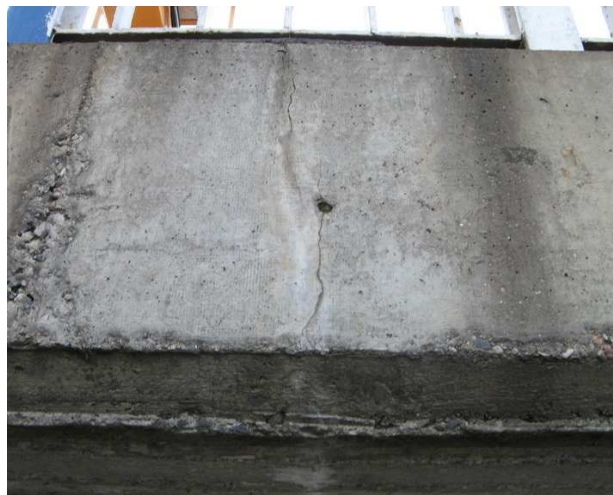
Fot. 59 Przykłady spękań gzymsów zlokalizowane na całej ich długości w rozstawach ~0,2 do 1,0m – głównie nad podporami
