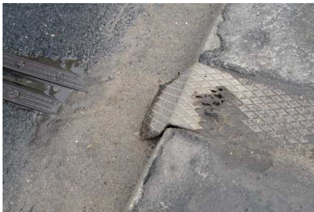
Fot. 8 Korozyjny ubytek przekrycia dylatacji oraz zanieczyszczenie piaskiem – na budynku elektrowni (z lewej) i na podporze w osi 2 (z prawej)
