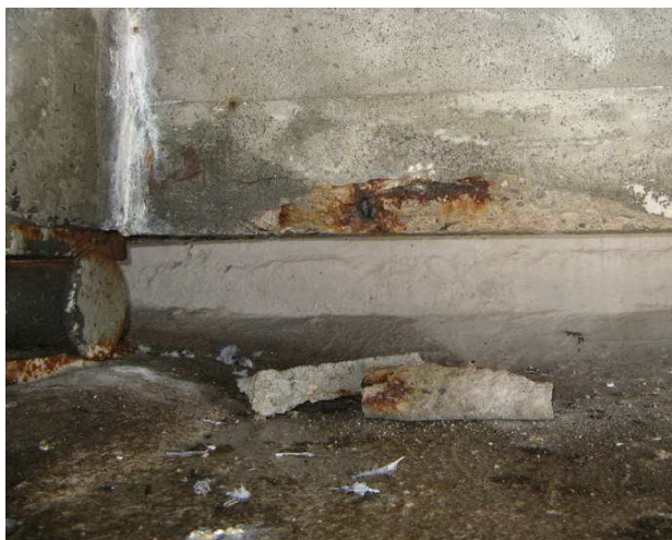
Fot. 56 Rysy oraz pęknięcia w dolnych partiach poprzecznie świadczące o korozji zbrojenia – występują na większości poprzecznic podporowych
