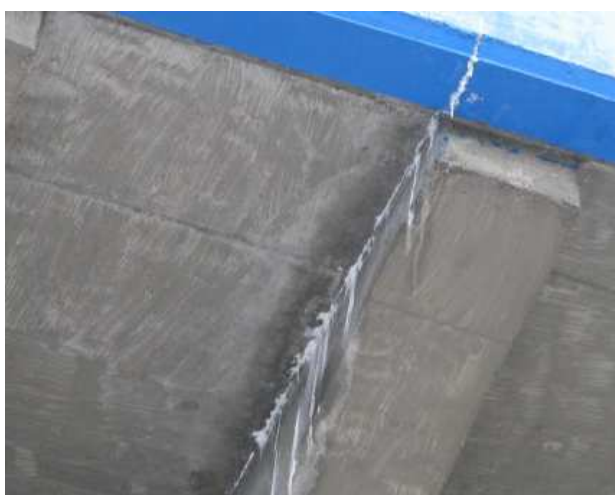
Fot. 31 Lokalnie widoczne pęknięcia na spodzie płyty oraz w gzymsie
