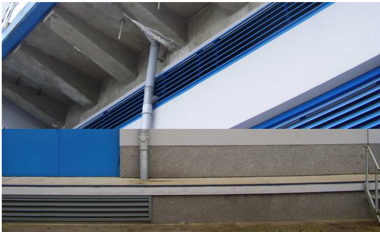
Fot. 37 Poprzecznice wspornikowo wysunięte poza ściany siłowni; rura spustowa na ścianie dolnego budynku
