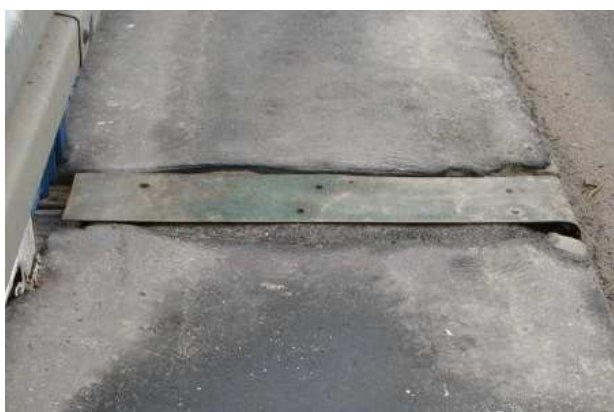
Fot. 13 Ubytki oraz deformacje nawierzchni chodnika nad podporą w osi 2 (z lewej), pęknięcie nawierzchni chodnika na uciągnięciu w podporze w osi 1 – styk obiektów na elektrowni i nad jazem
