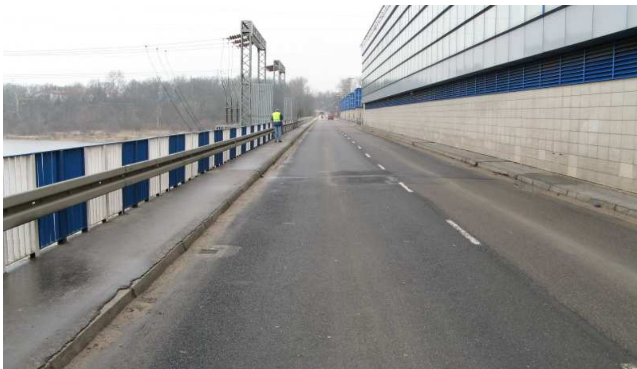
Fot. 3 Nawierzchnia obiektu na budynku elektrowni
