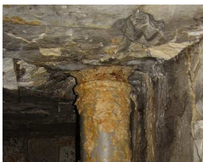
Fot. 27 Intensywne krystaliczne zacieki na w miejscach osadzenia rur spustowych
