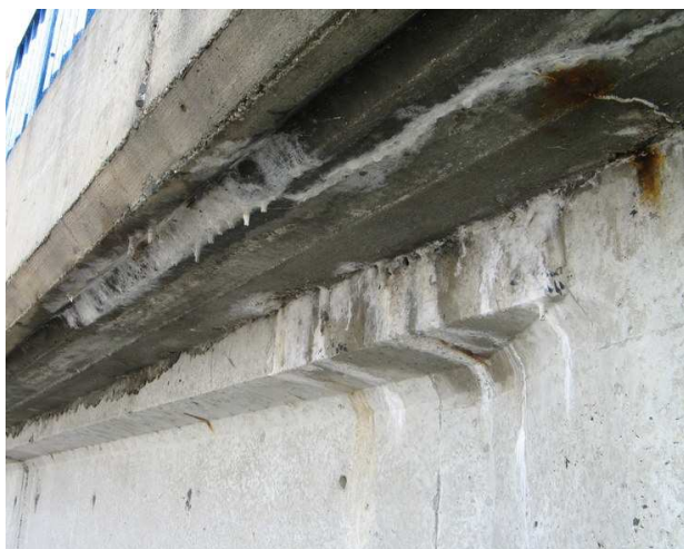
Fot. 48 Lokalnie występujące na obu wspornikach spękania wraz z intensywnymi krystalicznymi wyciekami
