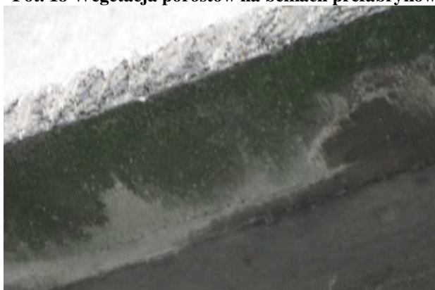
Fot. 19 Lokalne zawilgocenia spodów dźwigarów prefabrykowanych kolejno przęsła 4 DW i 7 GW
