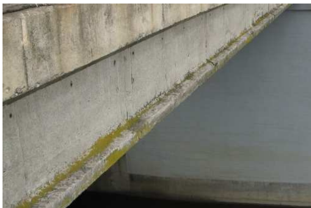
Fot. 18 Wegetacja porostów na belkach prefabrykowanych kolejno przęsła 8 i 5 od strony dolnej wody (DW)
