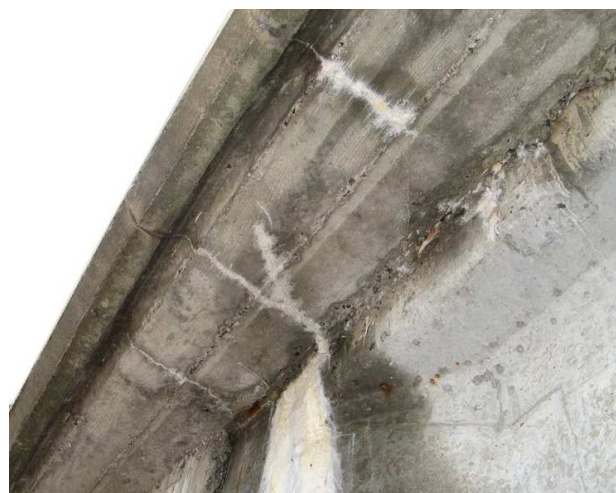
Fot. 48 Lokalnie występujące na obu wspornikach spękania wraz z intensywnymi krystalicznymi wyciekami
