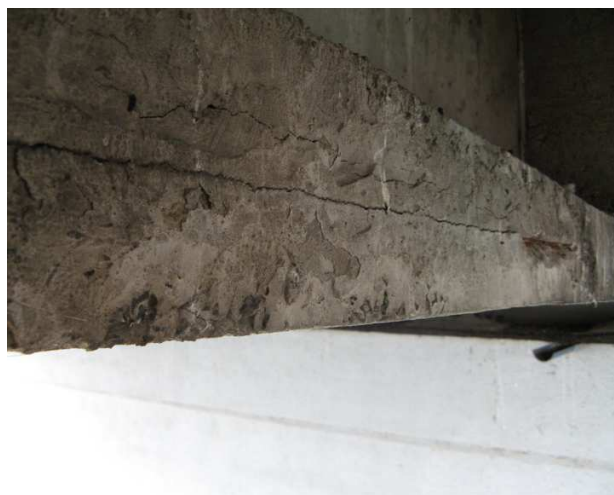
Fot. 50 Częste błędy wykonawcze – niedobetonowania oraz liczne raki w dźwigarach (lewe zdjęcie), a także rozwarstwienia półek dolnych już na etapie betonowania (prawe zdjęcie)
