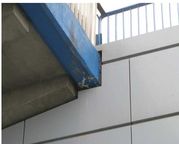
Fot. 42 Przyciółek od strony Legionowa, widoczne zacieki. Rura i szklana fasada wychodząca z elewacji.
