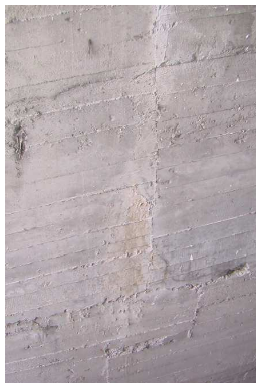
Fot. 34 Pęknięcie na całej wysokości podpory w osi 1
