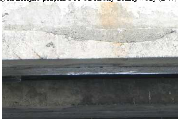
Fot. 19 Lokalne zawilgocenia spodów dźwigarów prefabrykowanych kolejno przęsła 4 DW i 7 GW
