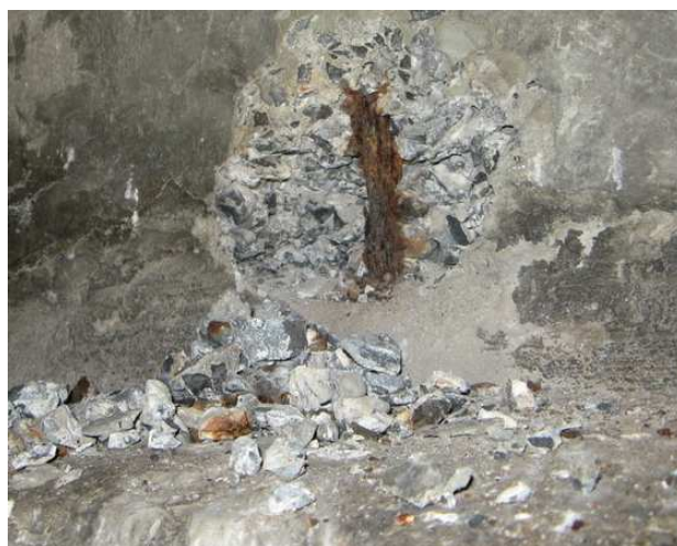
Fot. 51 Stwierdzone lokalnie niebezpieczne rozsegregowanie składników betonu – lico środka (z lewej), wyluskane kruszywo pozbawione spoiwa (z prawej)
