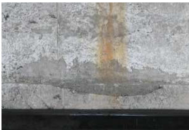
Fot. 21 Przykłady rozsegregowania mieszanki betonowej
