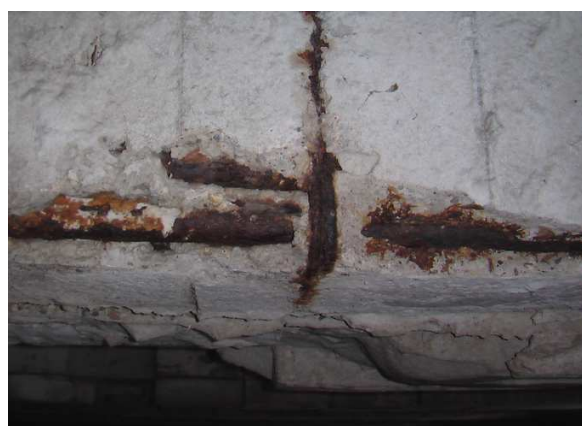
Fot. 23 Ubytki betonu oraz korozja odsłoniętego zbrojenia poprzecznicy przydylatacyjnej od strony GW (z lewej) oraz DW (z prawej)
