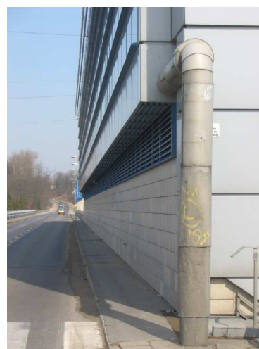
Fot. 42 Przyciółek od strony Legionowa, widoczne zacieki. Rura i szklana fasada wychodząca z elewacji.
