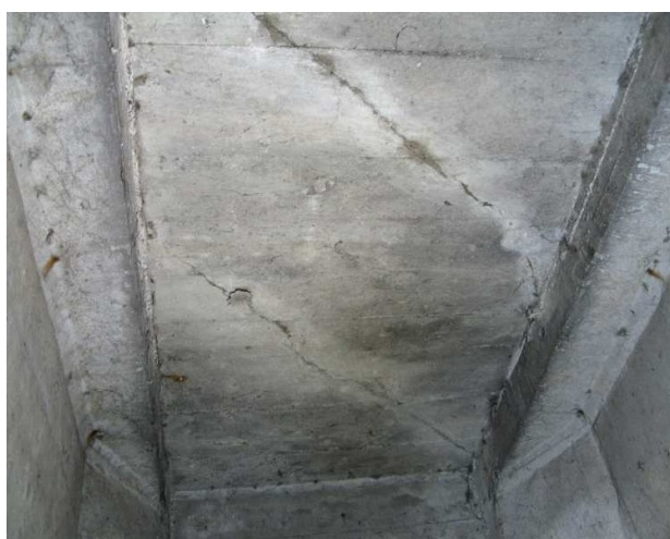
Fot. 45 Ukośne spękanie płyty pomostu występujące lokalnie w kilku polach
