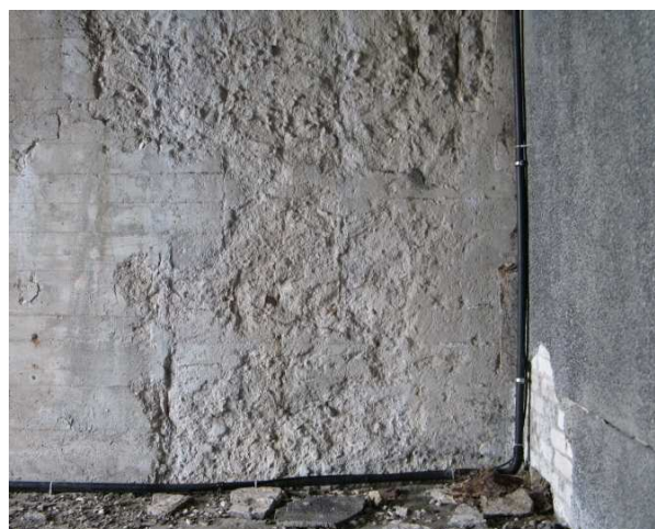
Fot. 33 Degradacja oraz ubytki betonu podpory w osi 1
