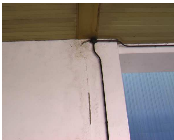
Fot. 36 Zacieki na ścianie wewnątrz budynku przy dylatacji
