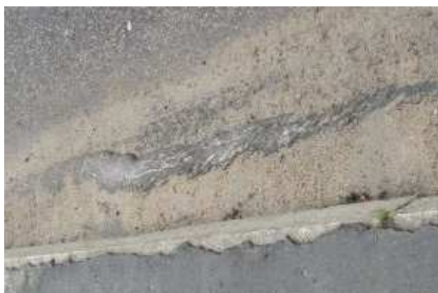
Fot. 12 Nieprawidłowości asfaltu lanego wypełniającego ściek przykrawężnikowy, ok. dwu metrowy „garb” w przeszle 8 od strony dolnej wody (z lewej), sfalowanie przy dylatacji na budynku elektrowni (z prawej)
