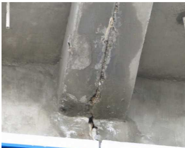
Fot. 32 Ubytki betonu przy dylatacji oraz wokół wpustu
