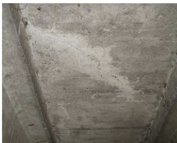
Fot. 45 Ukośne spękanie płyty pomostu występujące lokalnie w kilku polach
