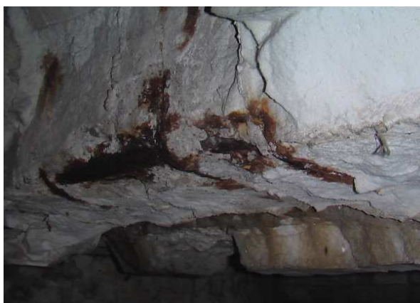
Fot. 23 Ubytki betonu oraz korozja odsłoniętego zbrojenia poprzecznicy przydylatacyjnej od strony GW (z lewej) oraz DW (z prawej)
