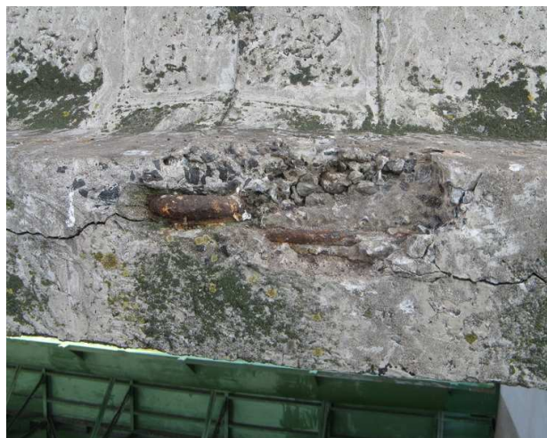
Fot. 49 Lokalnie występujące ubytki oraz spękania w półkach dolnych dźwigarów spowodowane korodującym zbrojeniem
