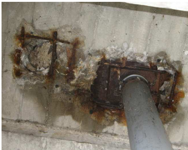
Fot. 43 Niewłaściwe osadzenie wpustów, ubytki betonu, zaawansowana korozja zbrojenia oraz widoczne przecieki wody i krystaliczne wykwity – opisane uszkodzenia występują wokół każdego wpustu
