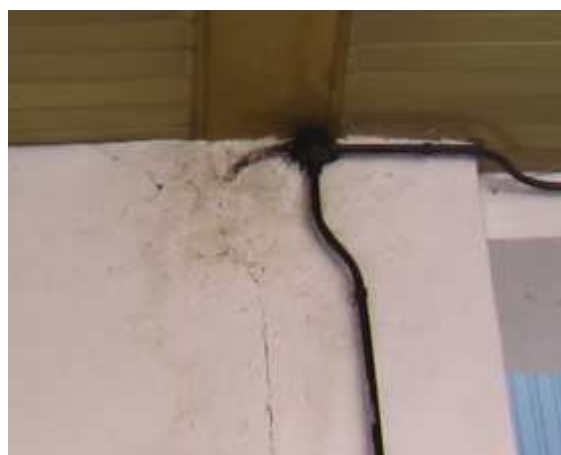
Fot. 36 Zacieki na ścianie wewnątrz budynku przy dylatacji
