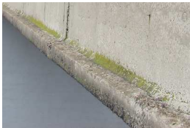
Fot. 18 Wegetacja porostów na belkach prefabrykowanych kolejno przęsła 8 i 5 od strony dolnej wody (DW)
