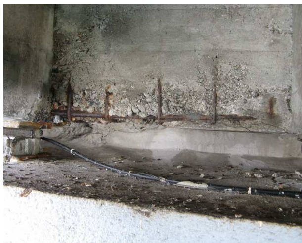
Fot. 55 Stwierdzono liczne przypadki ubytków betonu lub niedobetonowania poprzecznic a także korozję odsłoniętego zbrojenia
