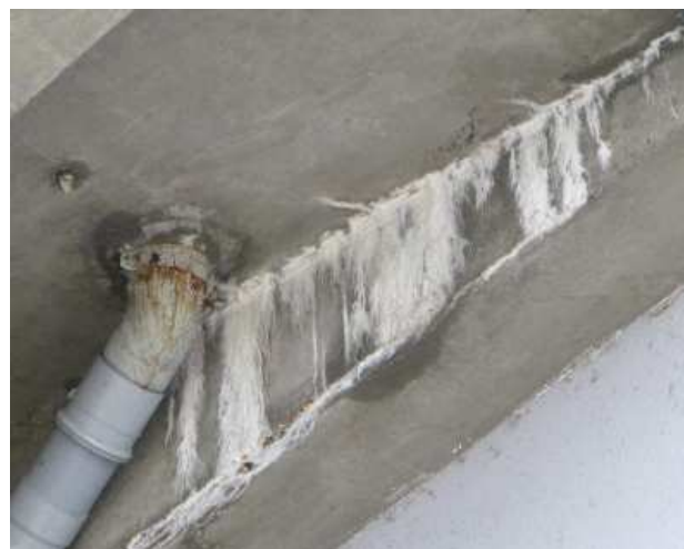
Fot. 30 Lokalnie wykwit na spodzie płyty oraz intensywne krystaliczne zacieki na żebrach wspornika
