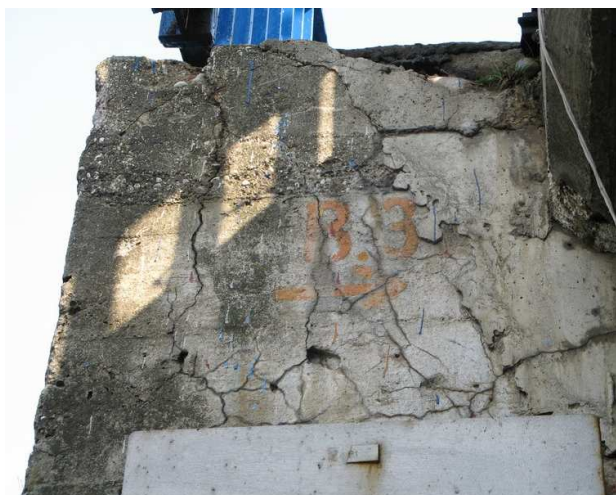
Fot. 60 Spękana ścianka zaplecza przyczółka od strony Nasielska (zdjęcie lewe) oraz oderwany kołnierz wałka łożyska w osi podpory 4 (strona prawa)
