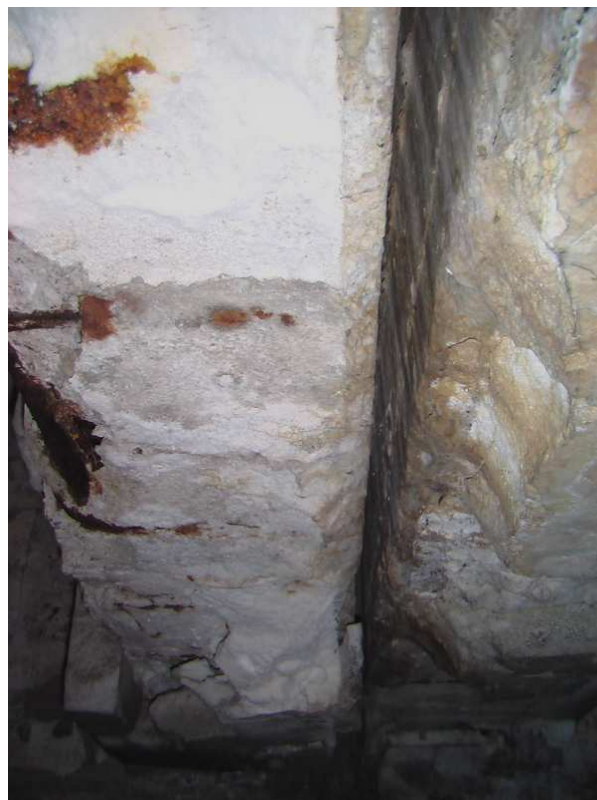
Fot. 22 Rysa pionowa w dźwigarze głównym na budynku elektrowni od strony górnej wody GW, dylatacja
