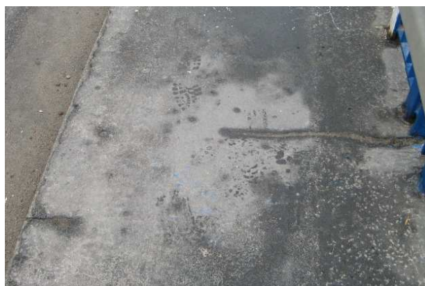
Fot. 13 Ubytki oraz deformacje nawierzchni chodnika nad podporą w osi 2 (z lewej), pęknięcie nawierzchni chodnika na uciągnięciu w podporze w osi 1 – styk obiektów na elektrowni i nad jazem
