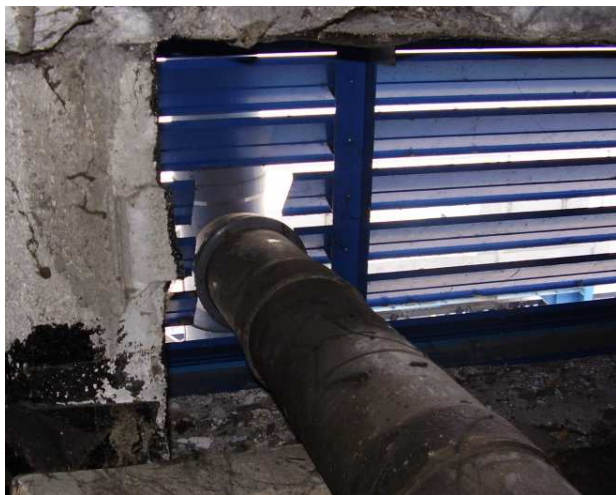
Fot. 38 Rura wychodząca przez okno budynku, krystaliczne stalaktyty pod belką mostu nad elektrownią (od strony górnej wody)
