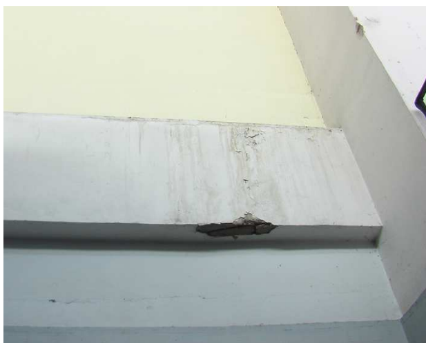
Fot. 35 Zacieki na dźwigarze głównym wewnątrz budynku
