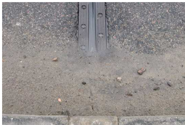
Fot. 8 Korozyjny ubytek przekrycia dylatacji oraz zanieczyszczenie piaskiem – na budynku elektrowni (z lewej) i na podporze w osi 2 (z prawej)
