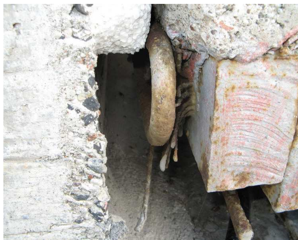
Fot. 57 Wzmoczona korozja większości zewnętrznych obetonowanych bloków kotwiących (z lewej), nieskorodowany nieobetonowany blok z prawej
