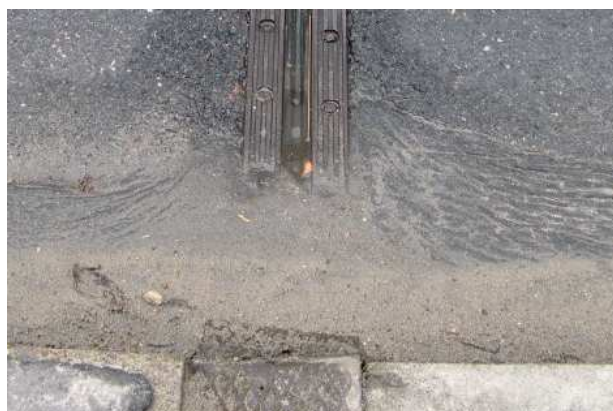
Fot. 12 Nieprawidłowości asfaltu lanego wypełniającego ściek przykrawężnikowy, ok. dwu metrowy „garb” w przeszle 8 od strony dolnej wody (z lewej), sfalowanie przy dylatacji na budynku elektrowni (z prawej)
