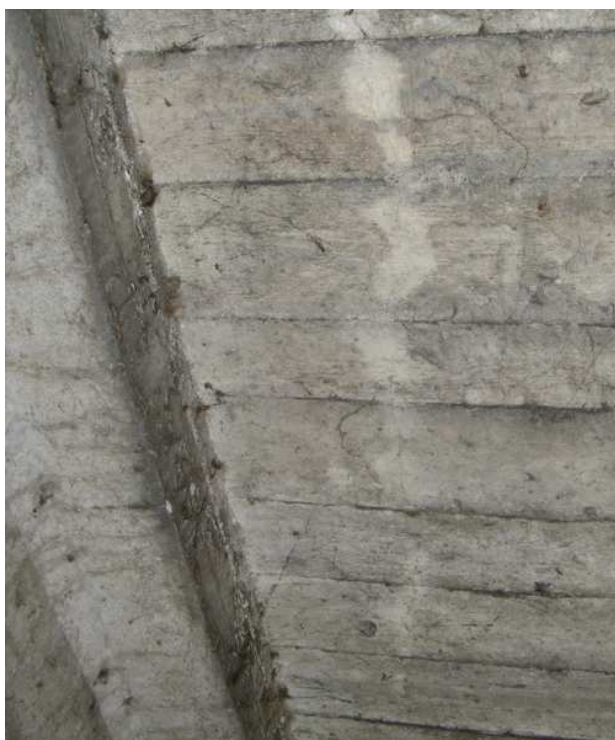
Fot. 46 Podłużne pęknięcia płyty pomostu występujące lokalnie w kilku polach
