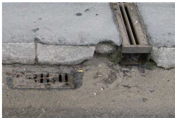
Fot. 9 Całkowicie niedrożny wpust w prześle nr 5 (z lewej) oraz przykład częściowego zanieczyszczenia (z prawej)
