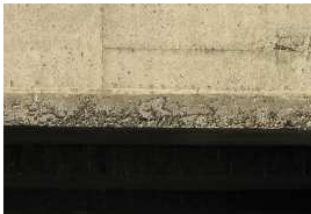
Fot. 21 Przykłady rozsegregowania mieszanki betonowej
