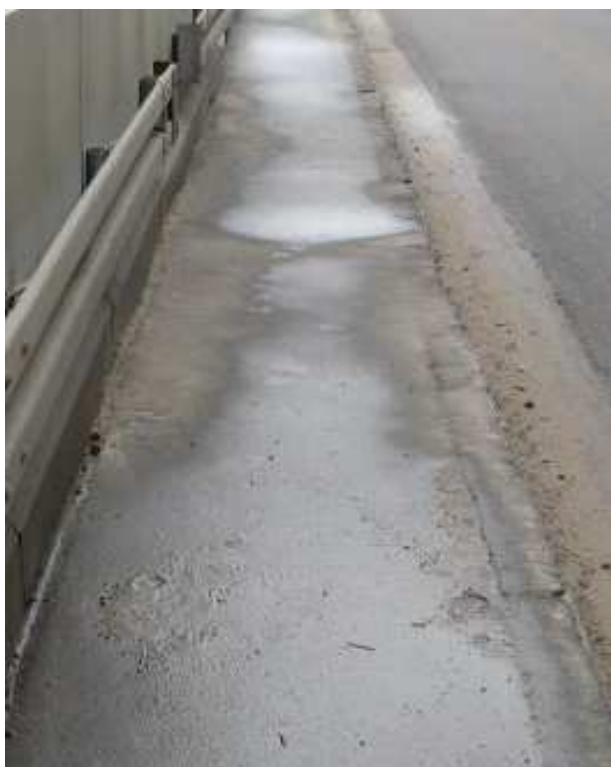
Fot. 11 Zastoiska wody spowodowane niewielkimi spadkami poprzecznymi chodników, piasek zalegający wzdłuż krawężników, most na budynku elektrowni (z lewej) oraz nad jazem (z prawej)
