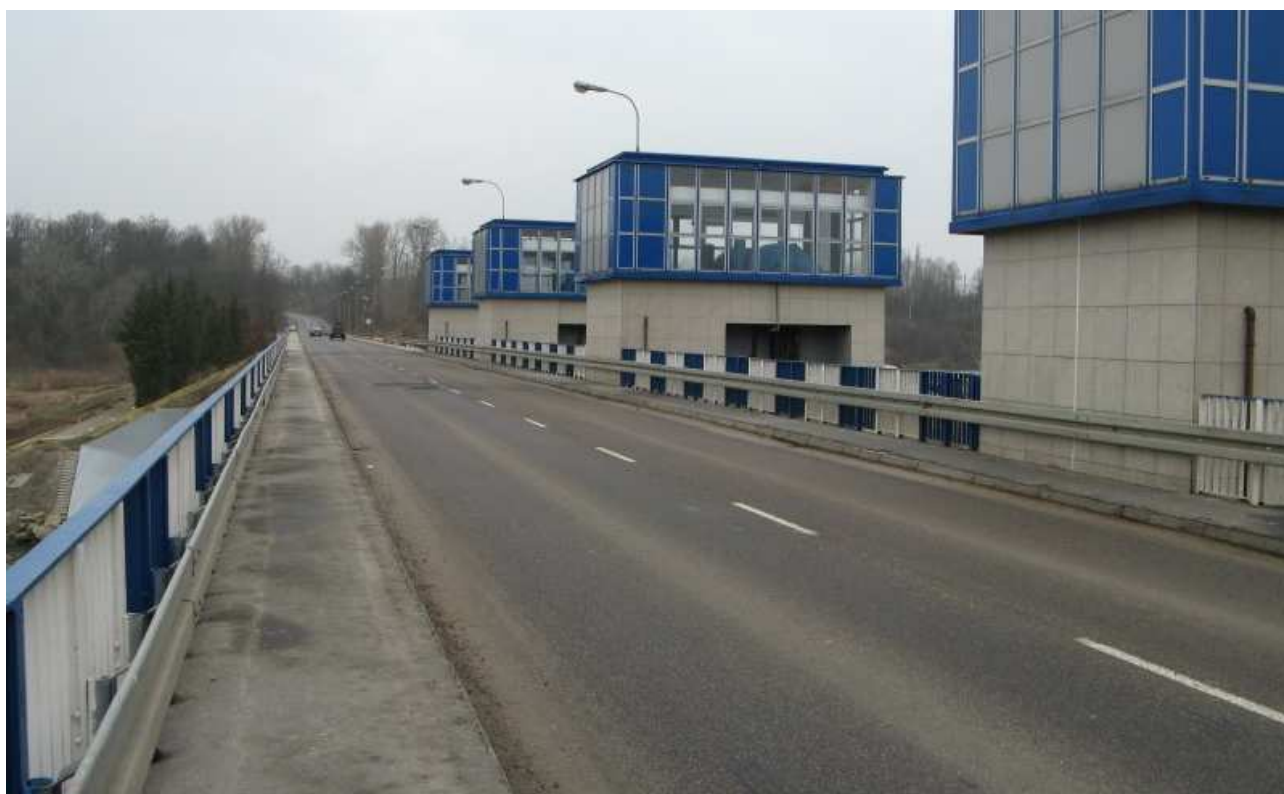
Fot. 4 Nawierzchnia obiektu nad jazem
