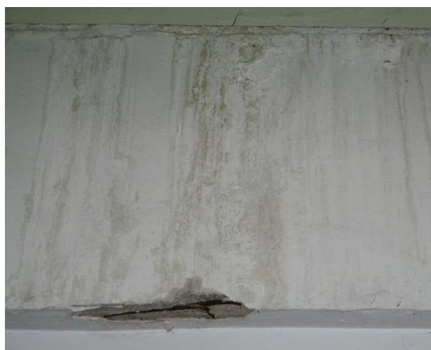
Fot. 35 Zacieki na dźwigarze głównym wewnątrz budynku
