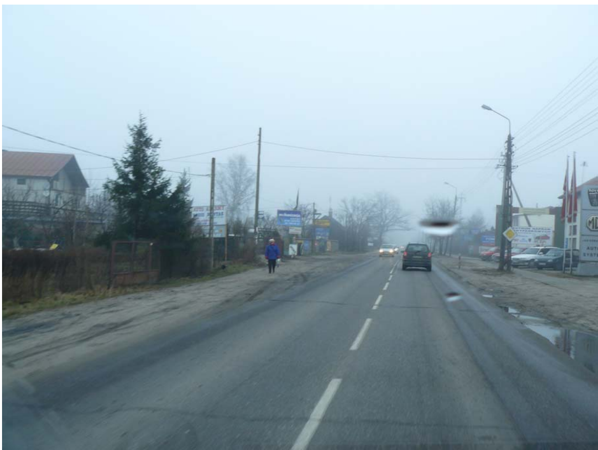
Fot. 4 Brak chodników, piesi poruszający się po poboczu, brak odwodnienia
