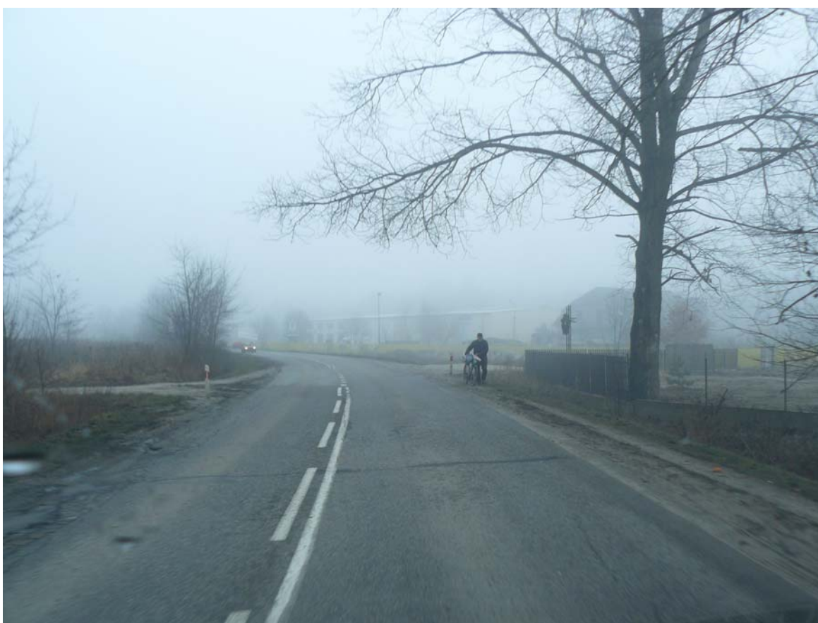
Fot. 8 Brak chodników, skrzyżowanie na łuku – ograniczona widoczność
