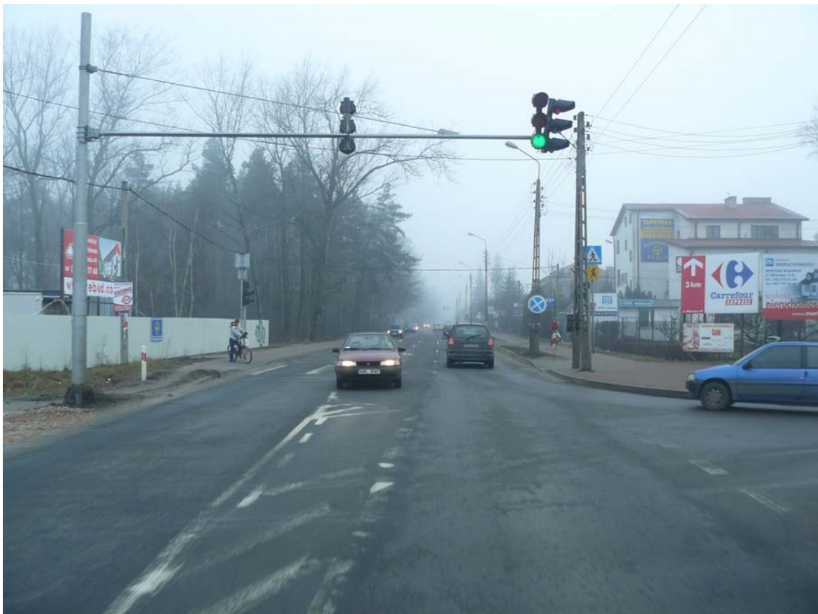
Fot. 3 Nieczytelne oznakowanie poziome, rowerzyści jeżdżą po chodniku
