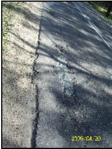
Fot. nr 1 Osęczyzna, km 46+500
