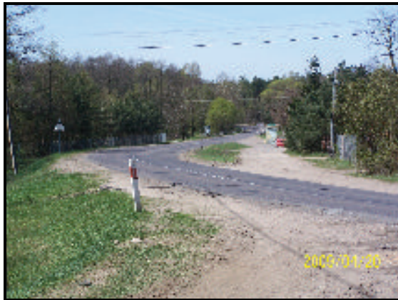
Fot. nr 2 Osęczyzna, km 46+690
