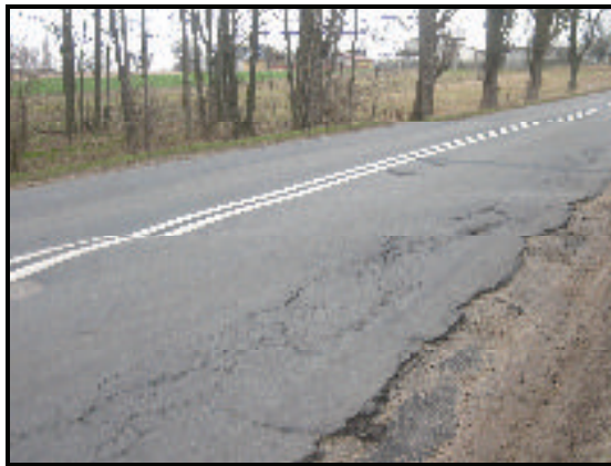
Fot nr 5 Zakrzew, km 60+580
