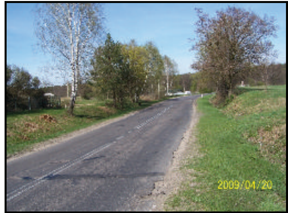
Fot. nr 3 Makówiec Duży, km 57+700
