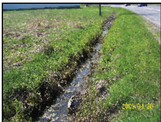
Fot nr 7 Dobrze, km 53+000
