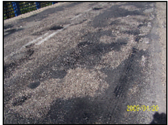
Fot nr 4 Makówiec Duży, km 58+150
