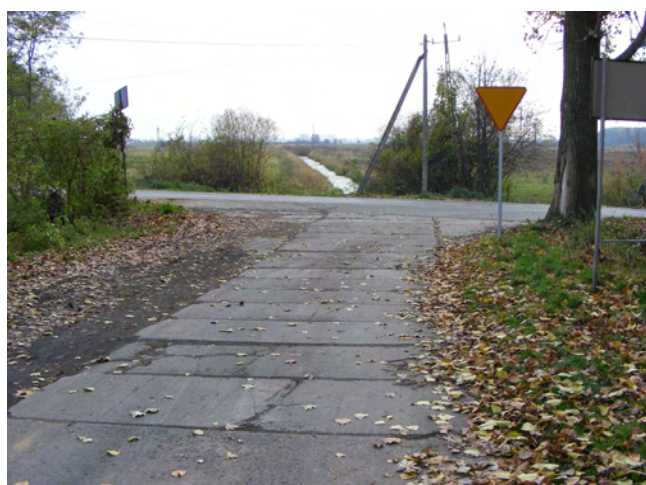
Fot. 6 Widok na rejon planowanego skrzyżowania obwodnicy z drogą nr 721 – punkt 4
