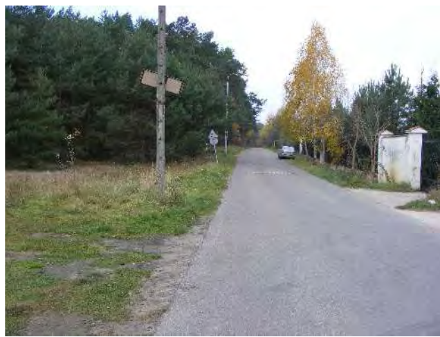
Fot. 12 Miejsce wejścia obwodnicy w drogę w Cięciszewie – odcinek 6-7
