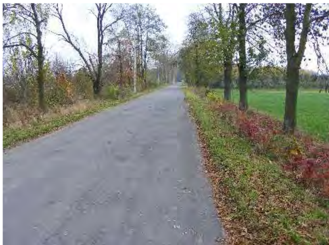
Fot. 14 Miejsce planowanego skrzyżowania obwodnicy z drogą do Cięciszewa – punkt 7
