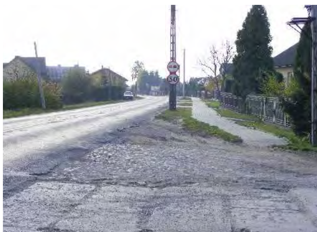
Fot. 14 Widok na istniejącą drogę 724 w miejscowości Moczydłów – punkt 12
