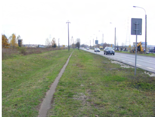
Fot. 2 Początek planowanej trasy – rejon skrzyżowania z istniejącą drogą nr 724 – punkt 0
