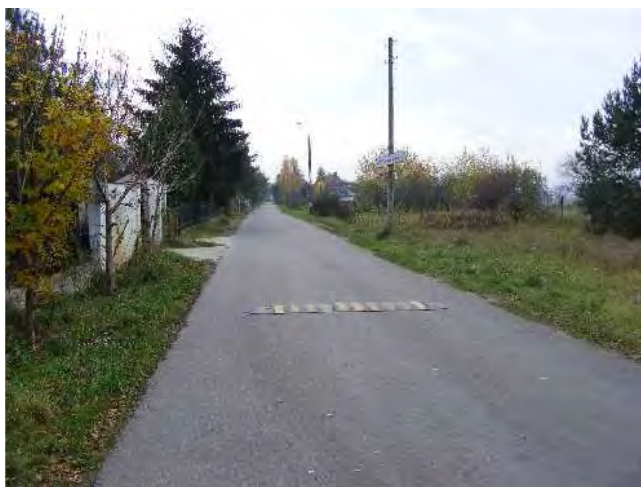
Fot. 11 Miejsce wejścia obwodnicy w drogę w Cięciszewie – odcinek 6-7
