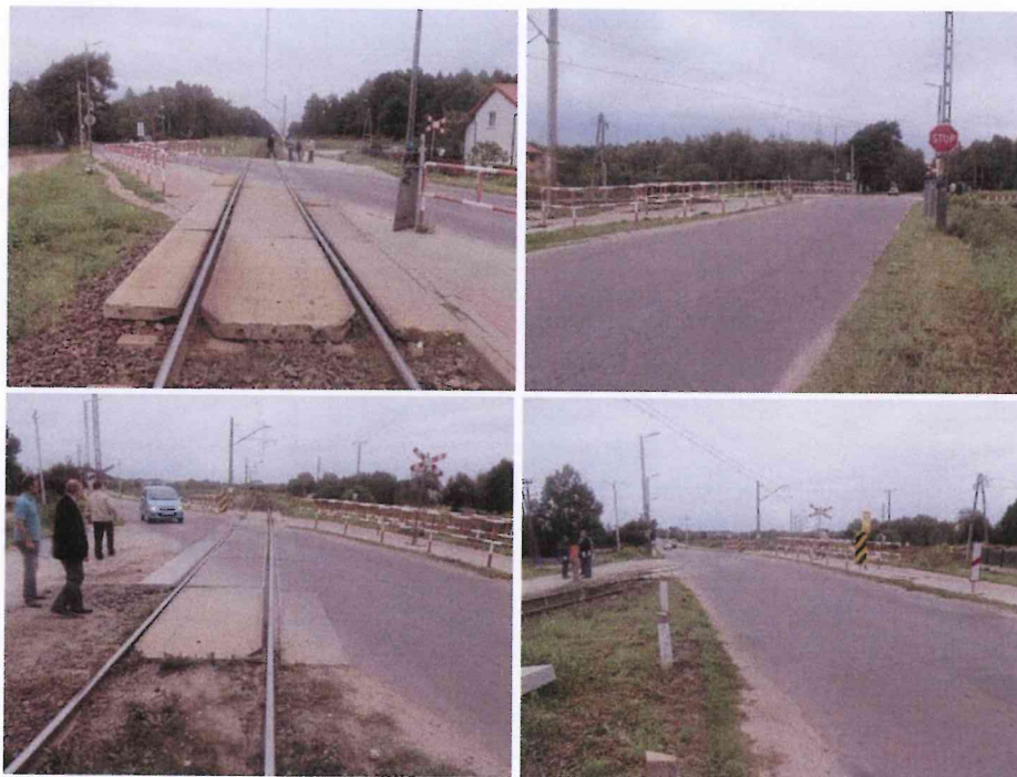
Zdjęcia przejazdu km 22,741 - stan istniejący
