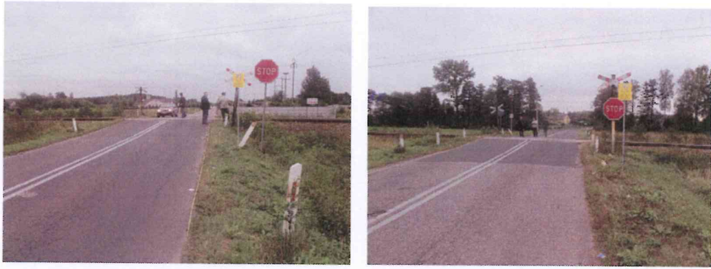
Zdjęcia przejazdu km 2,797 - stan istniejący
