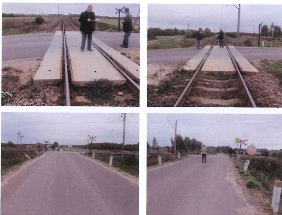
Zdjęcia przejazdu km 5,689 - stan istniejący
