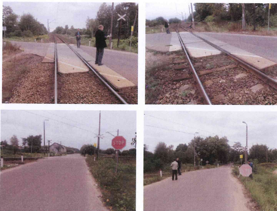
Zdjęcia przejazdu km 3,589 - stan istniejący
