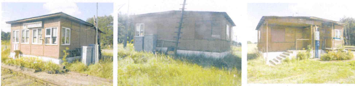
Zdjęcia nastawni dysponującej przewidzianej do likwidacji, powierzchnia zabudowy 53,94m 2 , kubatura 179,00m 3
