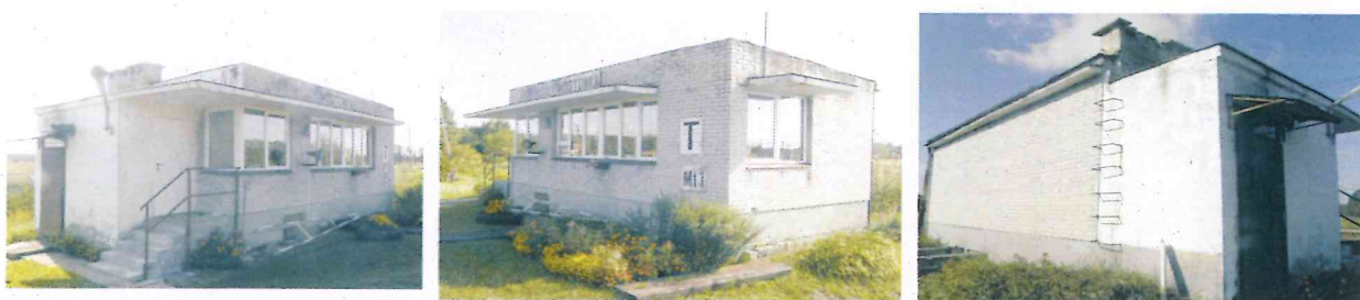
Zdjęcia nastawni wykonawczej przewidzianej do likwidacji, powierzchnia zabudowy 44,10m 2 , kubatura 193,00m 3
