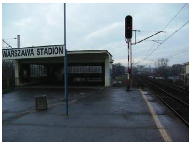
Rys. 2-2. Widok na wejście na peron przystanku kolejowego Warszawa Stadion.
