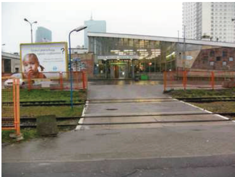
Rys. 2-4. Widok z peronu na budynek stacyjny, wewnątrz którego jest zejście na stację metra Dworzec Gdański.
