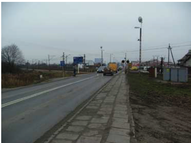
Rys. 2-11. Skrzyżowanie ul. Łodygowej z linią kolejową.
