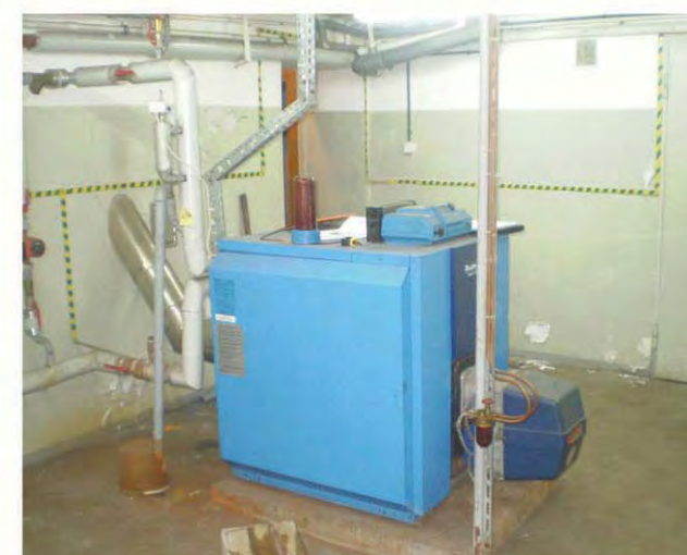
piwnice części wysokiej
