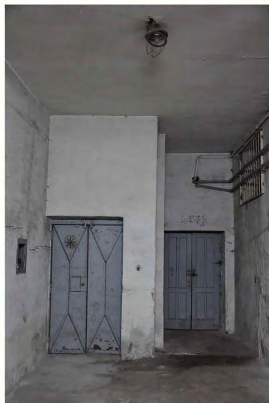
piwnica części niskiej
