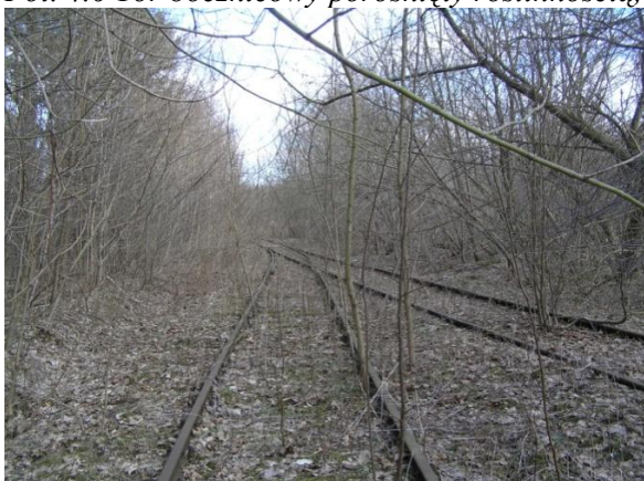
Fot. 4.7 Rozjazd zlokalizowany ok. km 5,300 z którego tory odchodzą do starej bazy paliw
