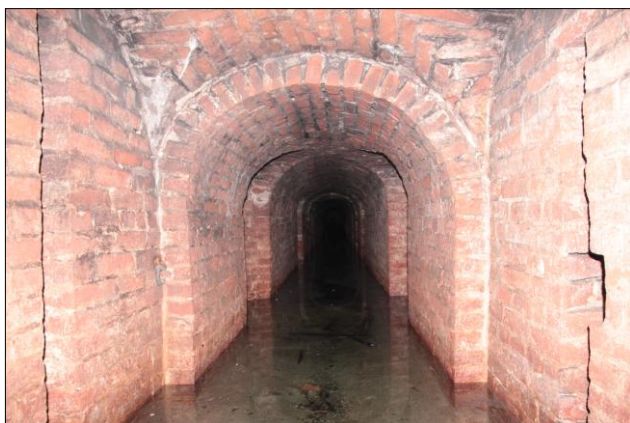
Ryc. 8. Widok korytarza centralnego zalanego wodą.
