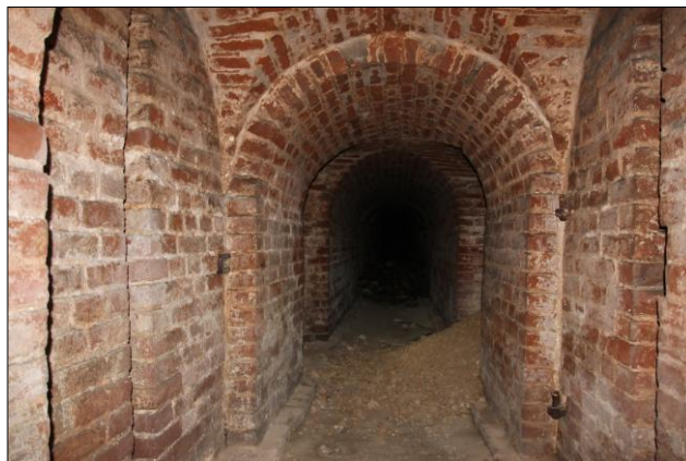
Ryc. 5. Widok chodnika zachodniego.
