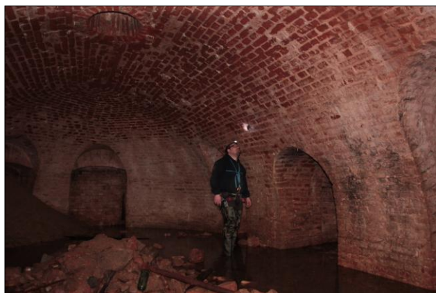
Ryc. 9. Sala końcowa korytarza centralnego.
