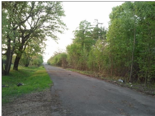
Ryc. 2. Droga dojazdowa do lotniska
