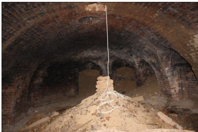
Ryc. 4. Wejście do zimowiska. Widoczny jest komin i wykuty otwór w suficie.
