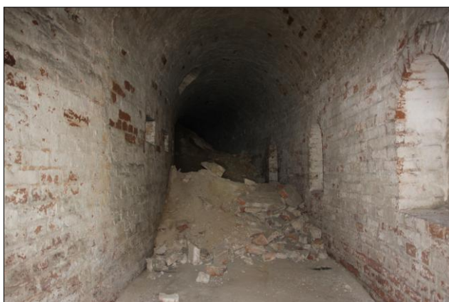
Ryc. 6. Widok łukowatego korytarza łączącego chodniki.
