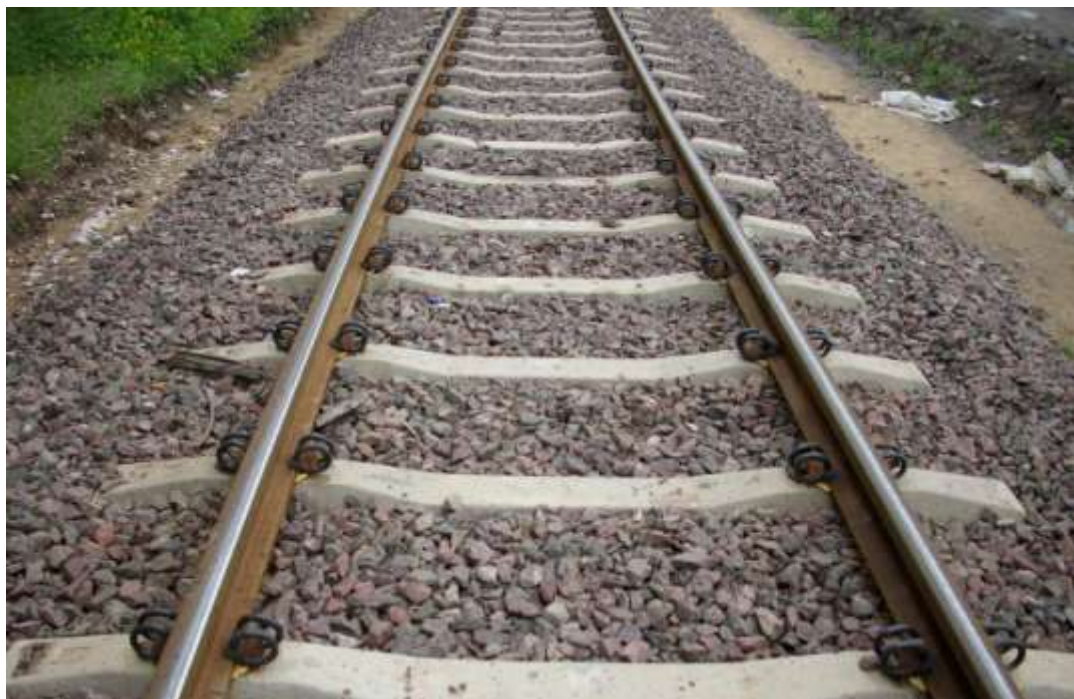
Fot. 12 – Tor główny bocznicy, nawierzchnia na podkładach PS 83 - S49, przytwierdzenia SB
