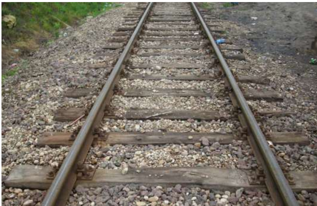
Fot. 13 – Tor główny bocznicy, nawierzchnia na podkładach drewnianych, przytwierdzenia K
