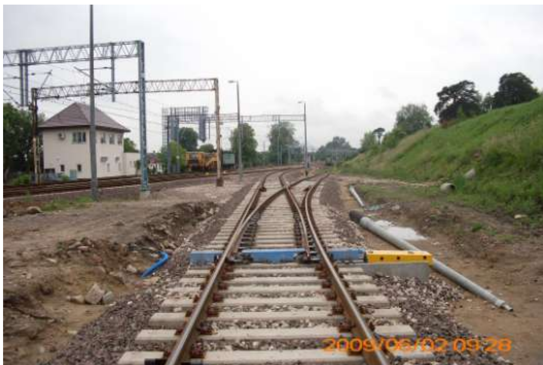
Fot. 18 – Rozjazd zwyczajny wbudowany w tor bocznicy podczas modernizacji stacji Modlin
