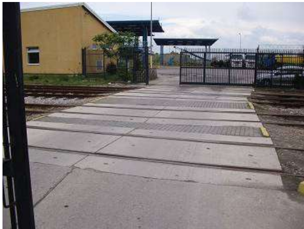
Fot. 29 – Przejazd w km 2,327
