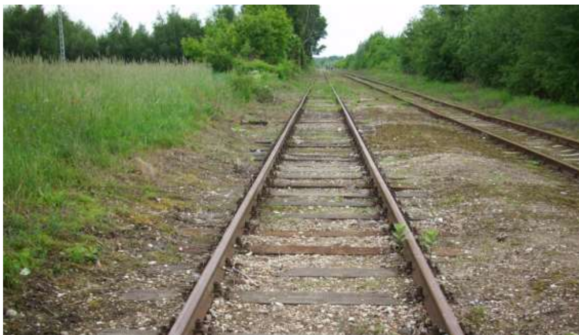
Fot. 16 – Tor mijankowy bocznicy, nawierzchnia na podkładach drewnianych, przytwierdzenia K
