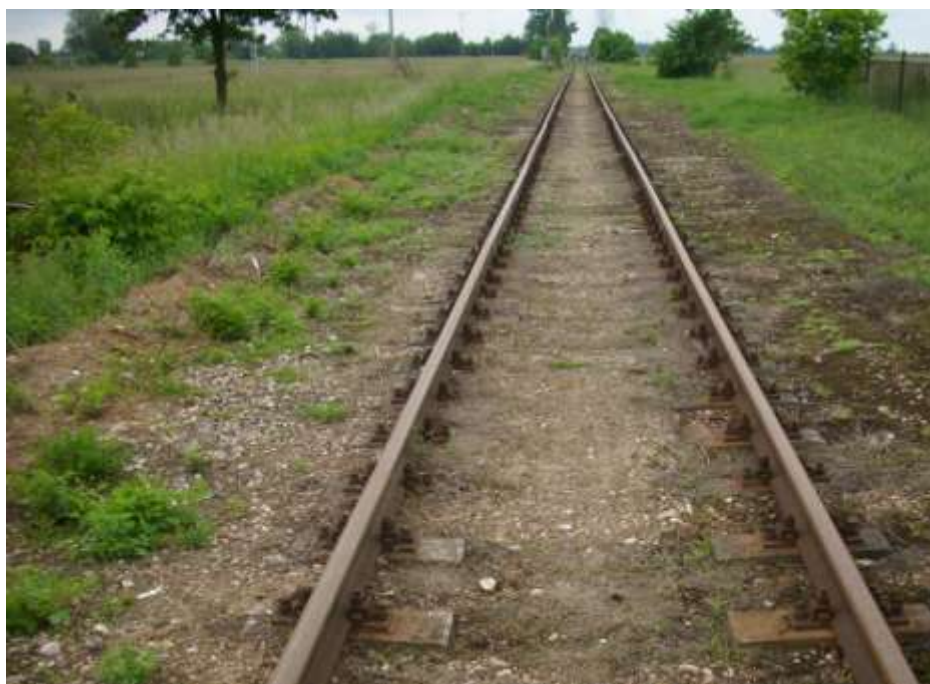
Fot. 8 – Tor główny bocznicy na prostej, od km 1,205 do km 1,575
