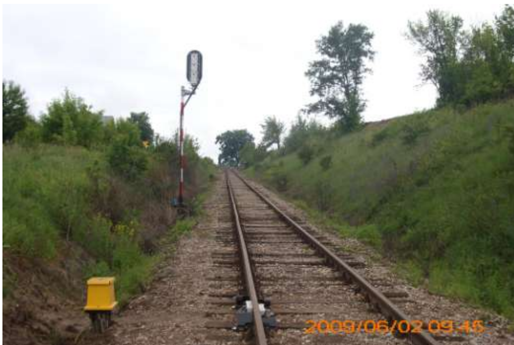
Fot. 6 – Tor główny bocznic na prostej, w przekopie, od km 0,610 do km 0,780
