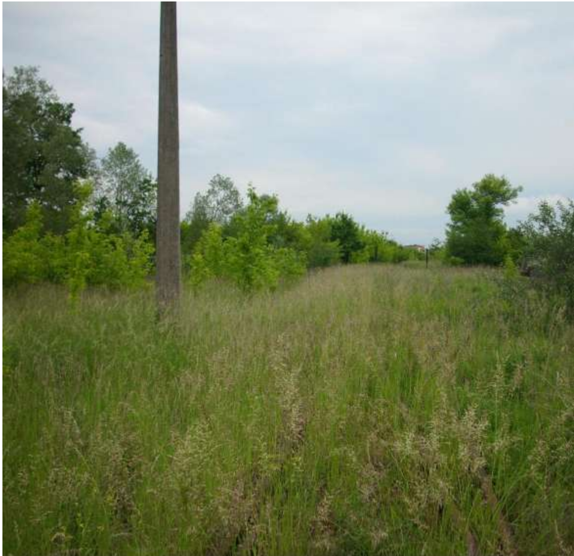
Fot. 24 – Rozjazd zwyczajny nr 39, porośnięty bujną trawą, km pocz. 2,706
