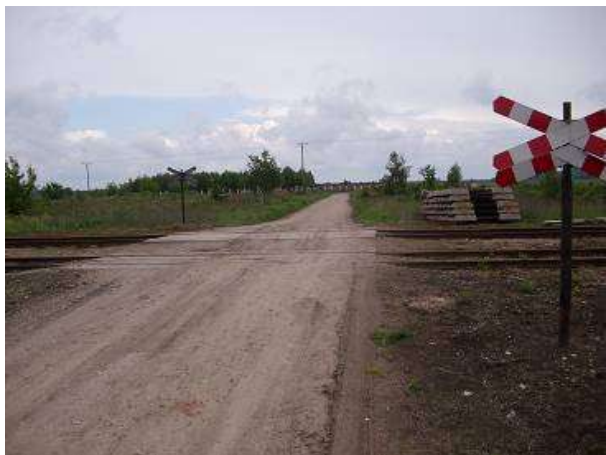
Fot. 28 – Przejazd w km 2,184
