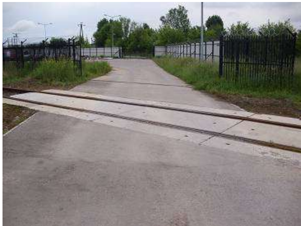
Fot. 30 – Przejazd w km 2,440
