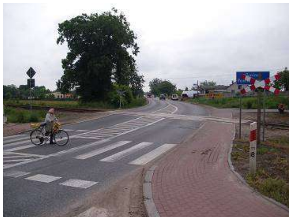
Fot. 26 – Przejazd w km 0,822
