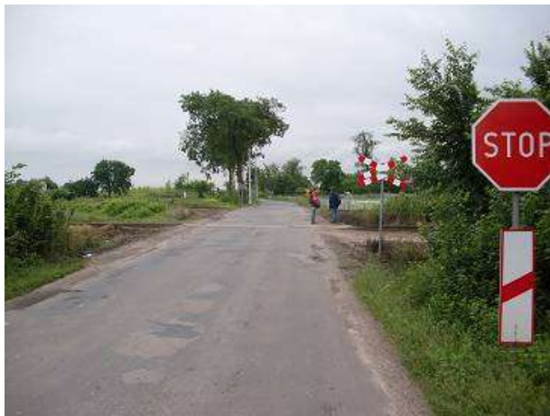
Fot. 27 – Przejazd w km 1,007
