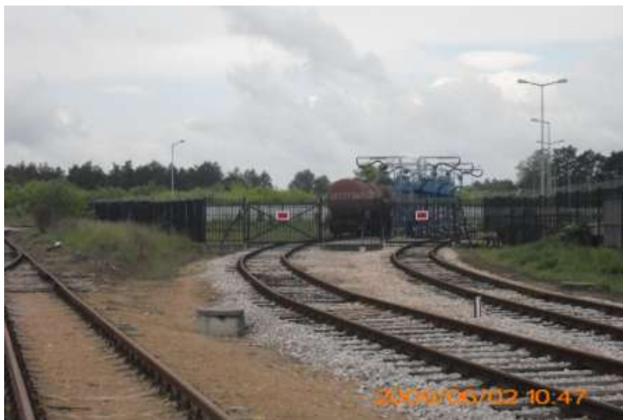
Fot. 1 – Wjazd do przepompowni paliw, km ~2,300
