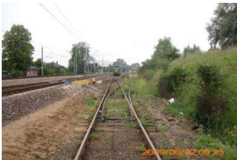
Fot. 17 – Rozjazd zwyczajny nr 21, należący do linii nr 9 (E65)
