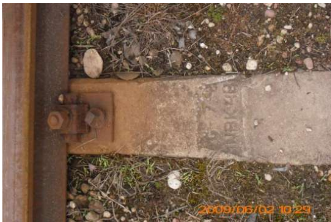
Fot. 15 – Tor główny bocznicy, nawierzchnia na podkładach INBK 4B, przytwierdzenia K
