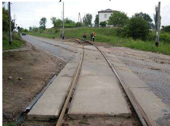
Fot. 25 – Przejazd w km 0,479
