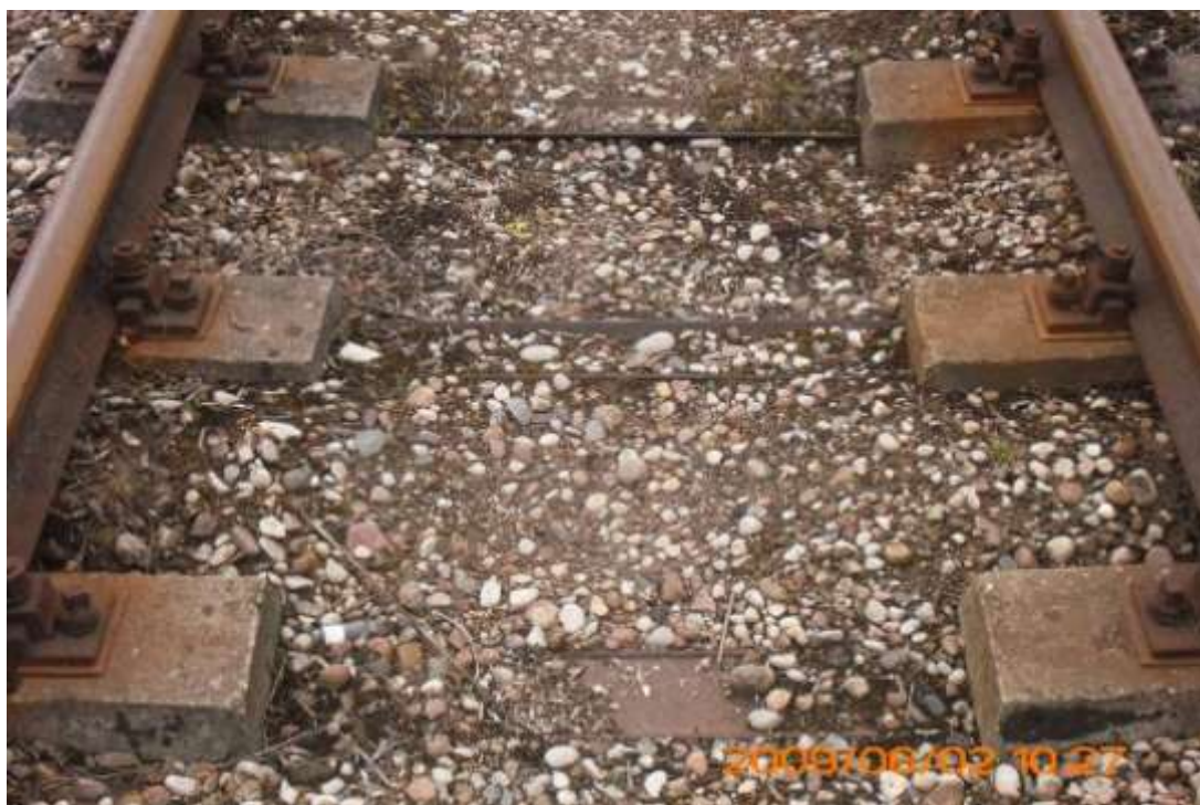
Fot. 14 – Tor główny bocznicy, nawierzchnia na podkładach GBL X, przytwierdzenia K
