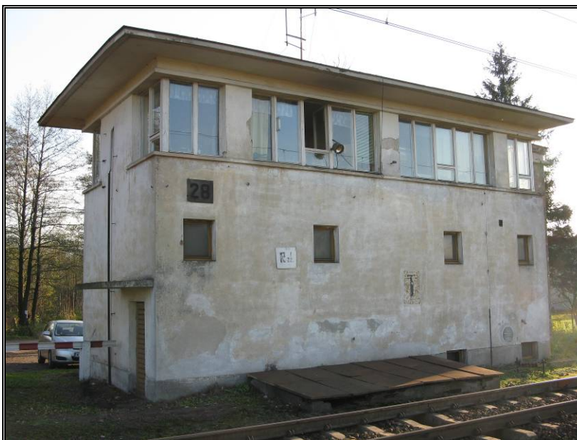
Fot. 21. Nastawnia dysponująca w Radziwillowie – widok z zewnątrz
