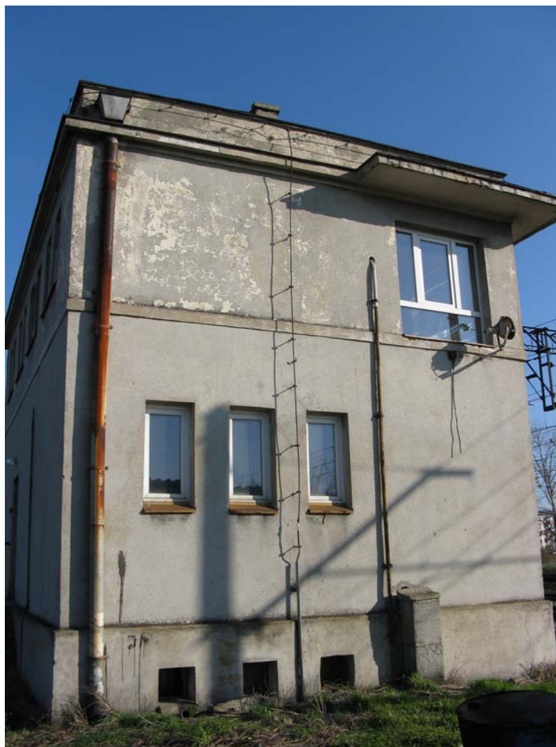
Fot. 15. Nastawnia wykonawcza w Pruszkowie – widok z zewnątrz
