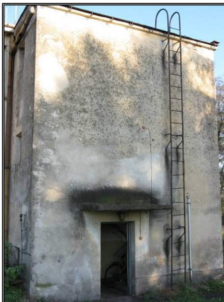
Fot. 22. Nastawnia dysponująca w Radziwillowie – widok z zewnątrz
