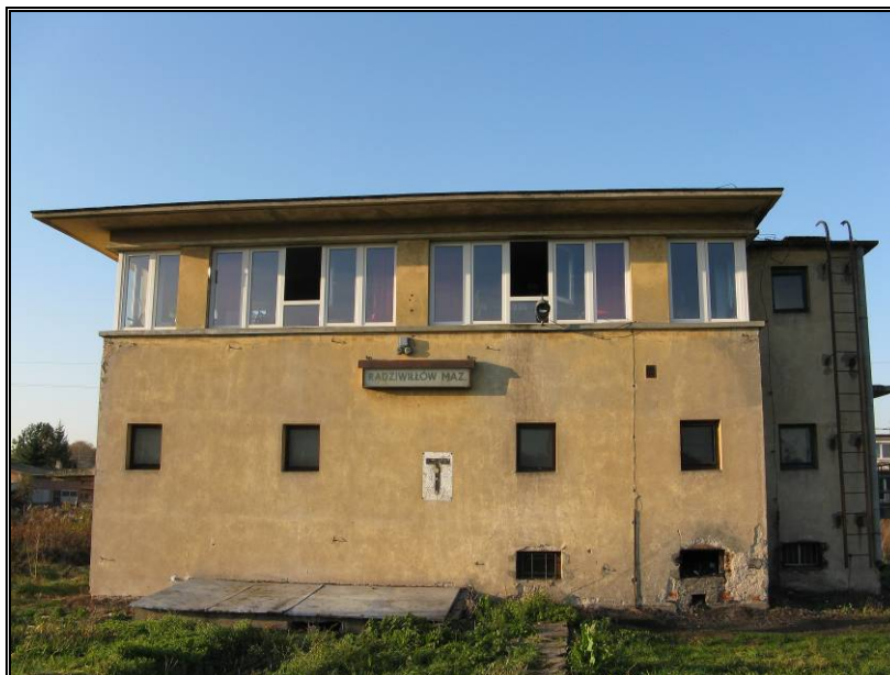
Fot. 18. Nastawnia wykonawcza w Radziwillowie – widok z zewnątrz
