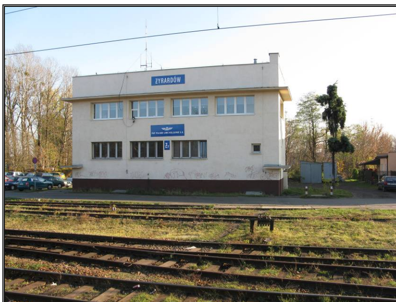
Fot. 24. Nastawnia w Żyrardowie – widok z zewnątrz
