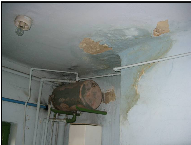
Fot. 20. Nastawnia wykonawcza w Radziwillowie - instalacje wewnętrzne
