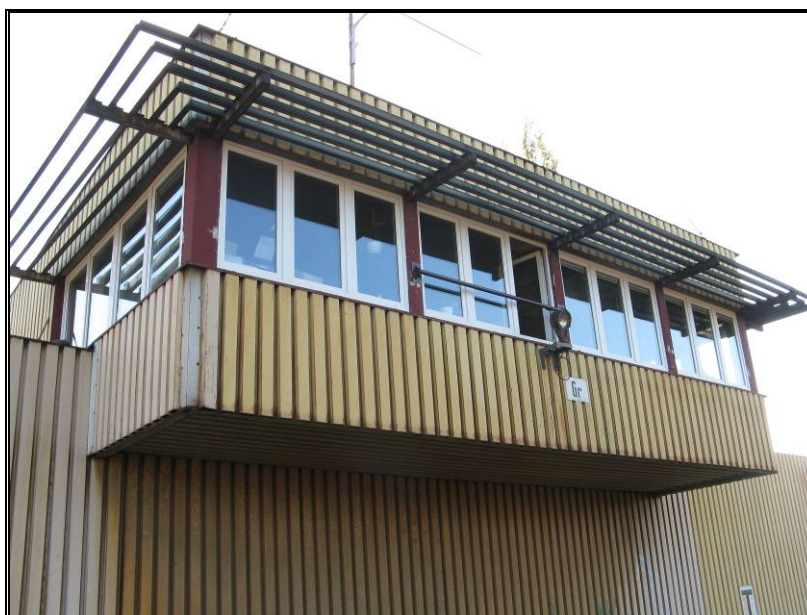
Fot. 17. Nastawnia w Grodzisku Mazowieckim –widok z zewnątrz
