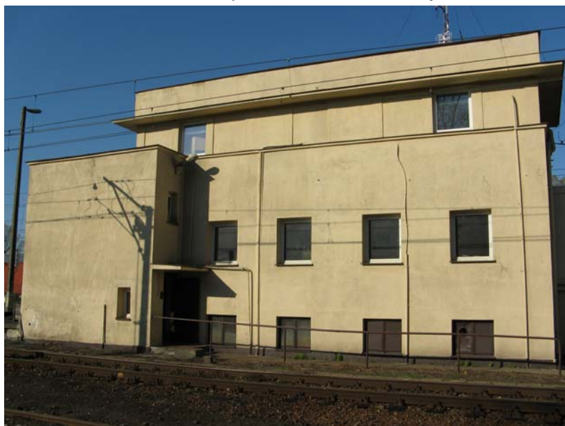
Fot. 19 Nastawnia dysponująca w Pruszkowie – widok z zewnątrz
