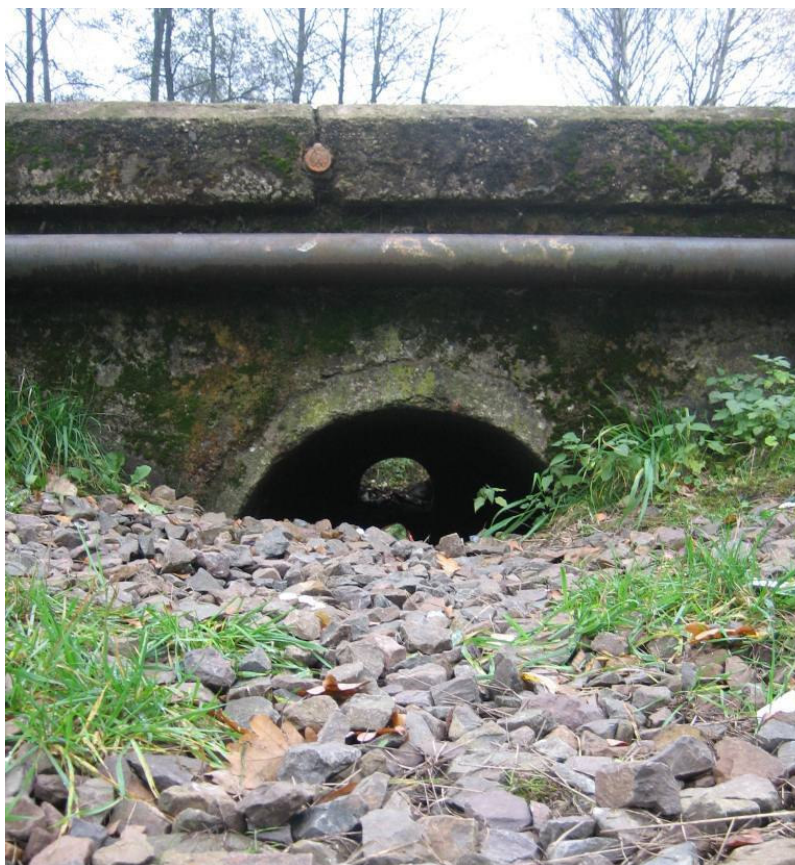
Zdj. 15. Przepust w km 44,824 przeznaczony do modernizacji (zwiększenie światła i budowa suchych półek).
