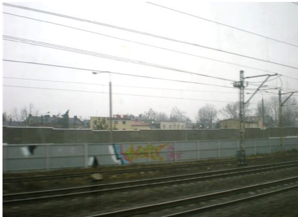
Zdj. 7. Zabudowa mieszkaniowa chroniona ekranem akustycznym (szlak Piastów-Pruszków). (Źródło własne)
