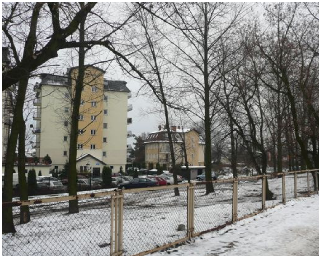
Zdj. 4. Zabudowa wielorodzinna w sąsiedztwie przystanku Warszawa Włochy (Źródło własne)
