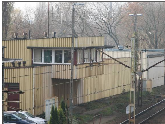
Fot. 3.9 Likwidowana nastawnia dysponująca na stacji Grodzisk Mazowiecki
