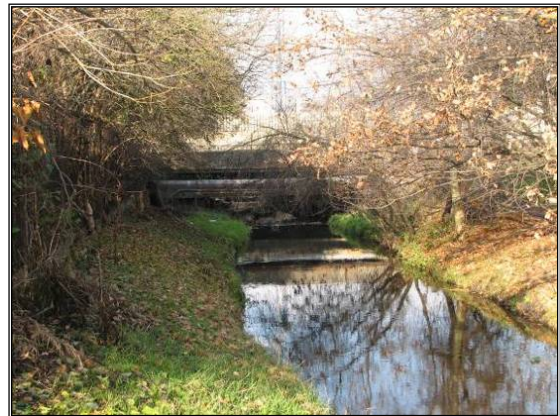
Fot. 5.20 Most nad rzeką Mrowną
