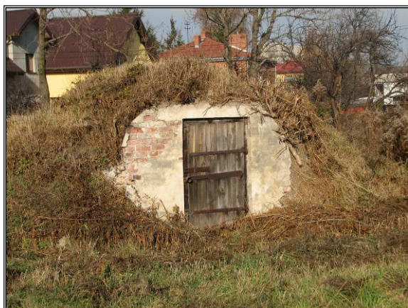
Fot. 3.12 Ceglana piwnica przy przejeździe w km 30+449
