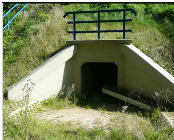
Fot. 5.23 Przykładowy przepust dla małych zwierząt z jednostronną suchą półką pod linią kolejową (odc. Skierniewice – Łódź)
