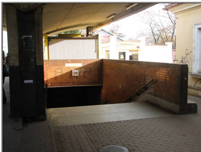
Fot. 3.6 Istniejące przejście podziemne dla pieszych przy stacji Grodzisk Mazowiecki
