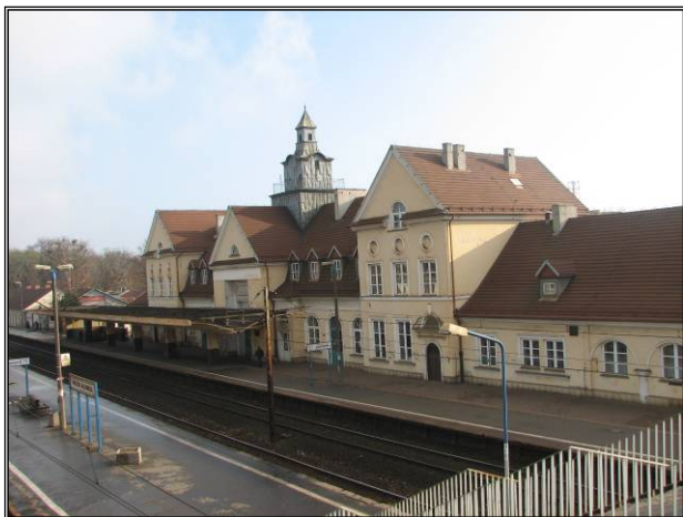
Fot. 5.26 Budynek dworca stacji Grodzisk Mazowiecki wraz z peronami
