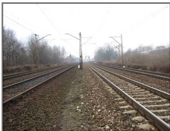
Fot. 5.1 Początek opracowania w km 28+100
