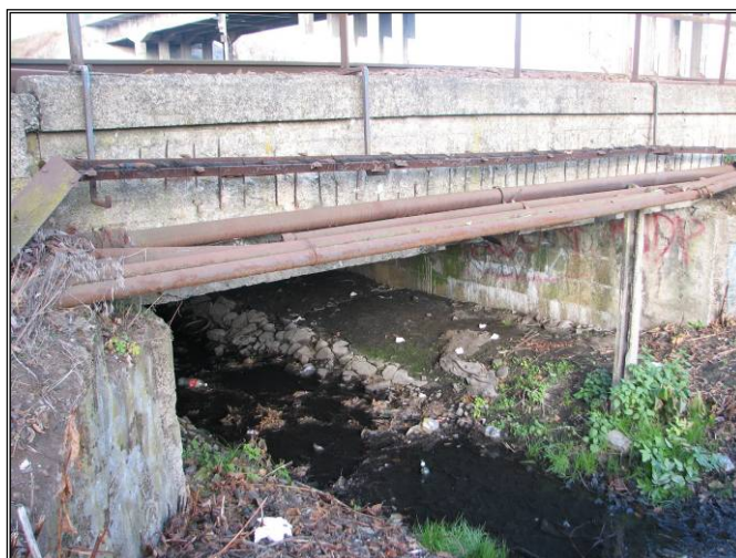
Fot. 3.5 Most kolejowy nad Rokicianką
