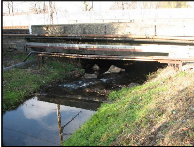
Fot. 3.7 Most kolejowy nad rzeką Mrowną
