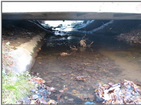
Fot. 5.19 Istniejące światło mostu nad rzeką Mrowną w Grodzisku Mazowieckim
