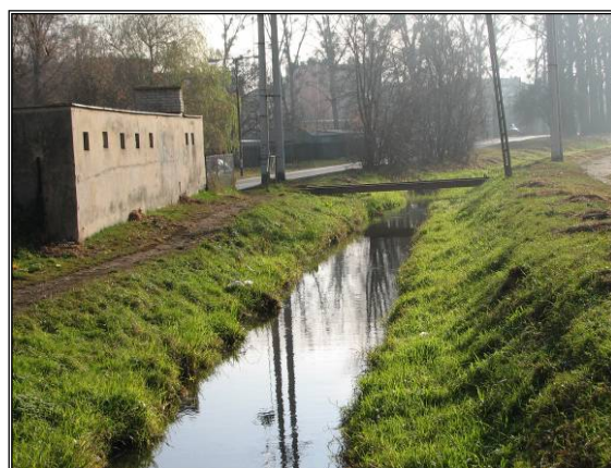
Fot. 5.9 Mrowna w Grodzisku Maz. w rejonie mostu kolejowego
