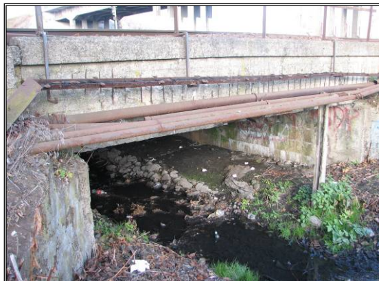
Fot. 5.15 Widok na istniejący most kolejowy nad Rokicianką
