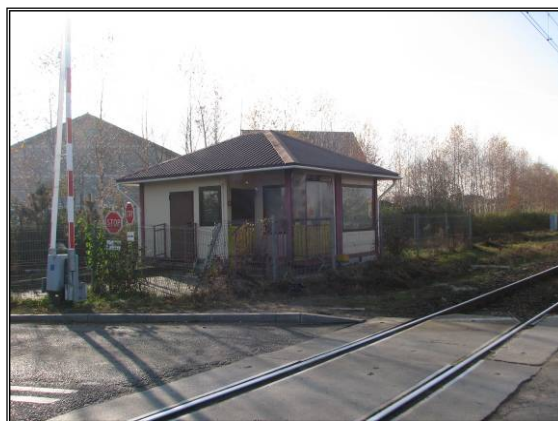
Fot. 3.13 Likwidowana strażnica przejazdowa w km 30+449
