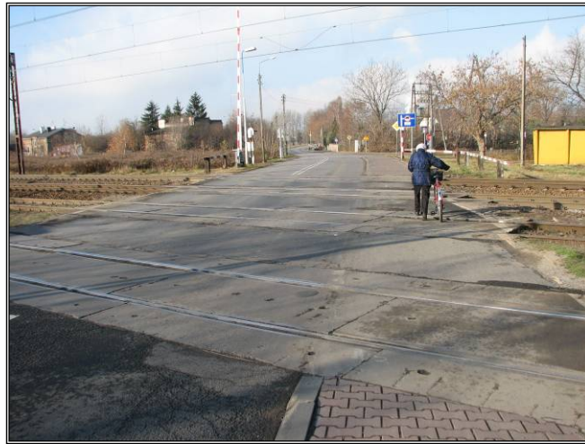
Fot. 3.4 Istniejący przejazd drogowy w ciągu ulicy Bałtyckiej w km 30+449
