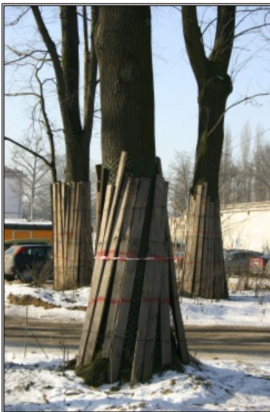
Fot. 5.14 Przykładowy sposób ochrony pnia drzewa przed uszkodzeniami związanymi z pracami wykonywanymi w jego pobliżu
