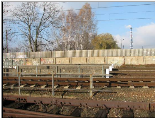
Fot. 5.22 Widok na mur odgradzający linię kolejową od terenów przemysłowych i przecinający rzekę Mrowną
