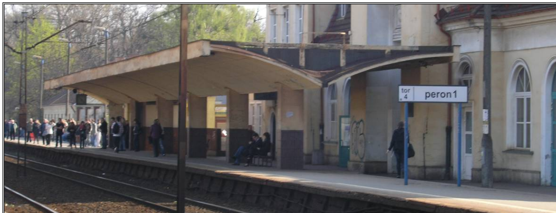
Fot. 3.11 Zadaszenie nad schodami na Peronie Nr 1 przewidziane do rozbiórki [63]
