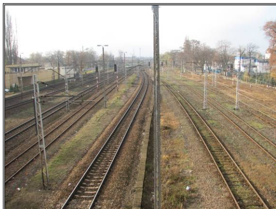
Fot. 5.5 Układ torów w rejonie stacji Grodzisk Mazowiecki
