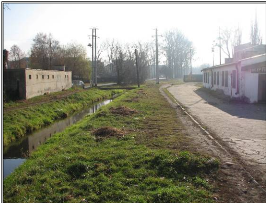
Fot. 5.21 Otoczenie koryta rzeki Mrownej w rejonie mostu kolejowego
