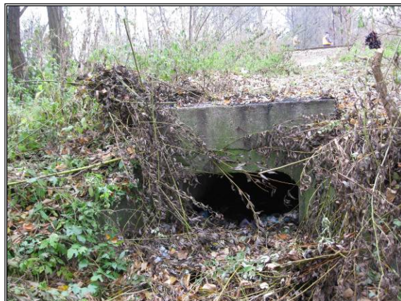
Fot. 3.8 Przepust w km 30+936 w stanie istniejącym
