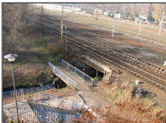
Fot. 5.17 Widok na most i kładkę dla pieszych nad rzeką Rokicianką po południowej stronie linii kolejowej
