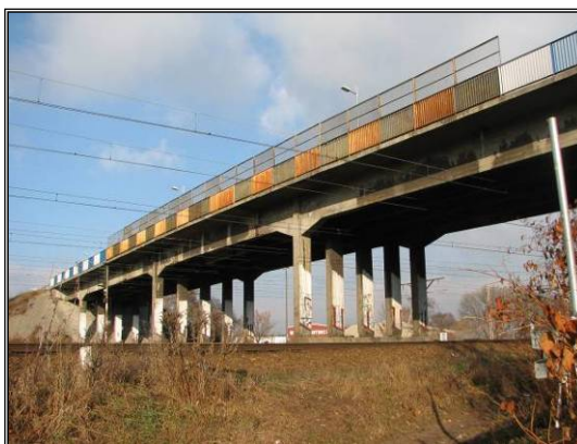
Fot. 5.2 Wiadukt nad linią kolejową - ulica Okulickiego
