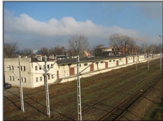
Fot. 3.10 Budynki magazynowe i schronisko ISE przewidziane do rozbiórki
