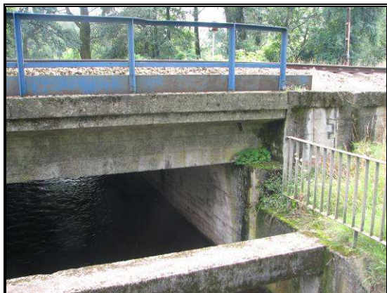
Fot. 3.5 Most na Kanale Ulgi (km 43+784)
