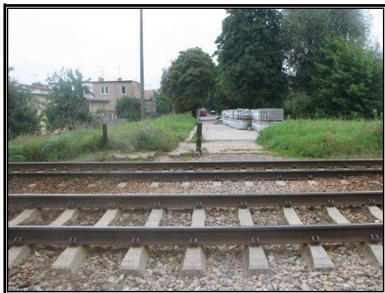
Fot. 3.3 Przejście dla pieszych w km 44+084,47
