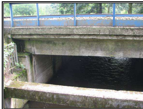
Fot. 5.7 Most kolejowy nad Kanałem Ulgi od strony mostu drogowego
