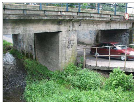
Fot. 3.8 Most na rzekę Pisią Gągoliną i ulicą Św. Jana (km 43+861)
