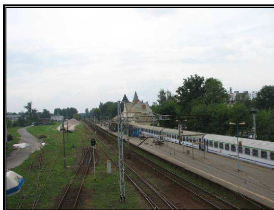
Fot. 3.2 Widok na peron oraz budynek dworca w Żyrardowie
