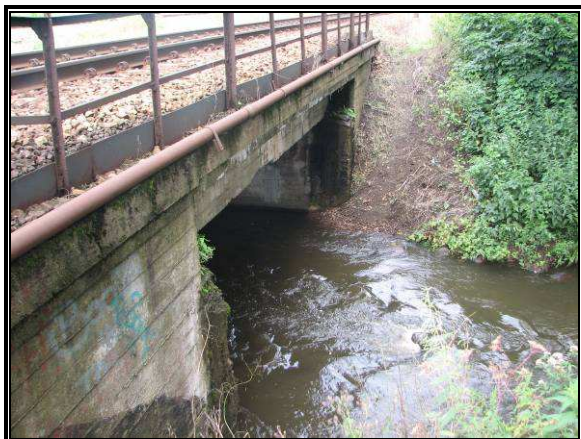
Fot. 5.6 Most kolejowy nad Kanałem Ulgi
