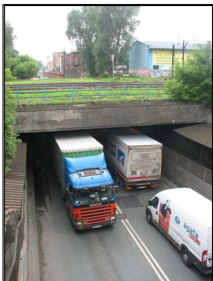
Fot. 3.7 Wiadukt nad drogą krajową nr 50- km 43+474
