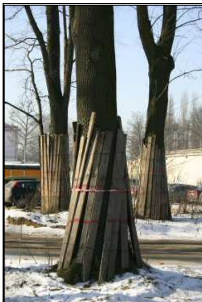
Fot. 5.1 Przykładowy sposób ochrony pnia drzewa przed uszkodzeniami związanymi z pracami wykonywanymi w jego pobliżu
