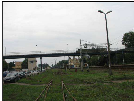
Fot. 3.6 Kładka przeznaczona do likwidacji (42+962)
