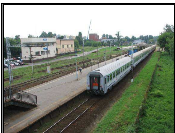
Fot. 3.1 Widok na peron i nastawnie w Żyrardowie, przeznaczone do rozbiórki
