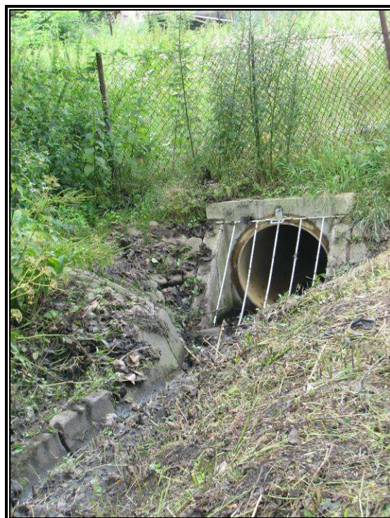
Fot. 5.3 Włączenie rowu burzowego po północnej stronie od torów do kanalizacji deszczowej biegnącej pod ziemią
