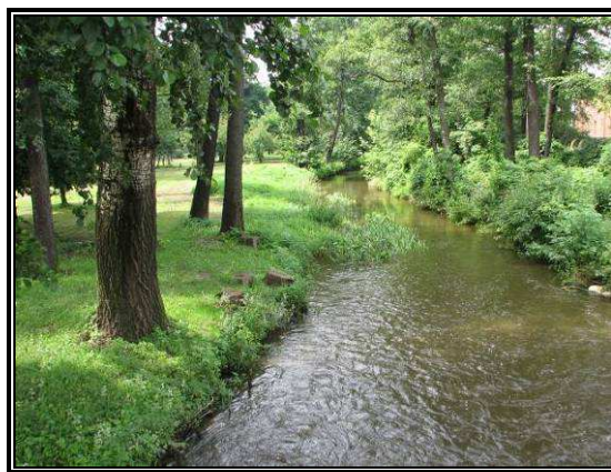
Fot. 5.5 Kanał Ulgi przepływający przez park przy ulicy Wyspiańskiego w okolicy Zakładów Wyrobów Włókienniczych
