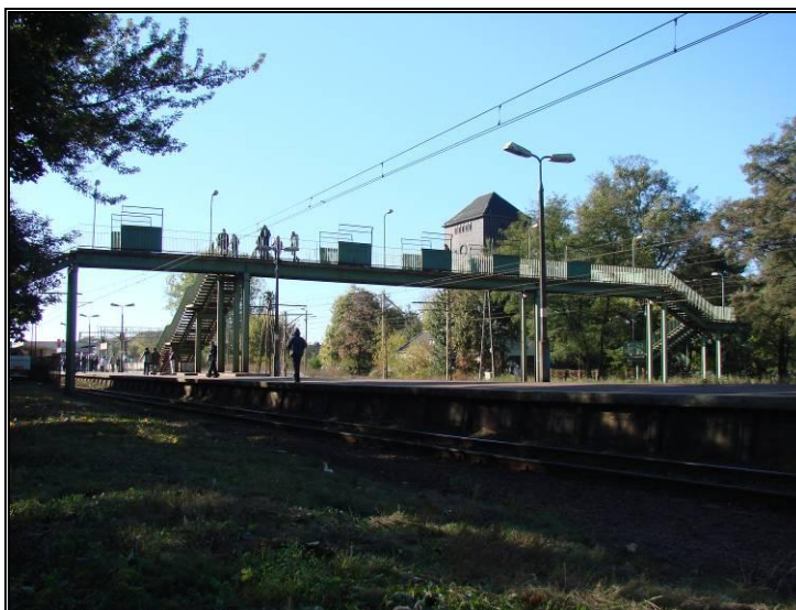
Fot. 3.4 Kładka dla pieszych przy dworcu na Stacji Pruszków
