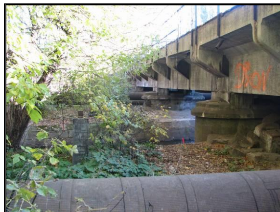
Fot. 5.22 Most nad Utratą w stanie istniejącym
