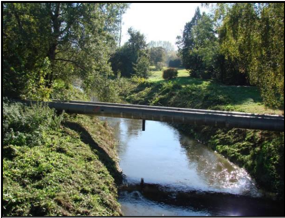
Fot. 5.17 Zagospodarowanie terenu po południowej stronie mostu nad Utratą
