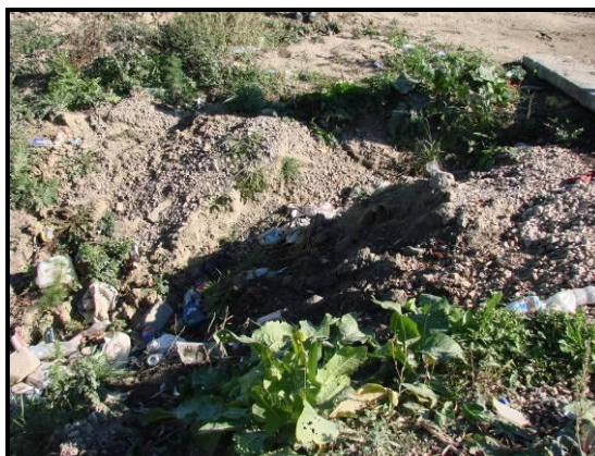
Fot. 3.9 Widok przepustu od strony północnej (zasypany wlot)
