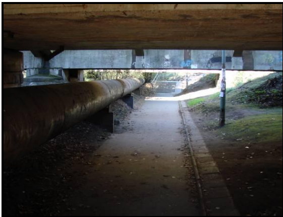
Fot. 5.19 Ciąg dla pieszych pod mostem
