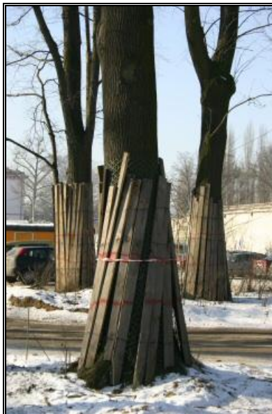
Fot. 5.16 Przykładowy sposób ochrony pnia drzewa przed uszkodzeniami związanymi z pracami wykonywanymi w jego pobliżu
