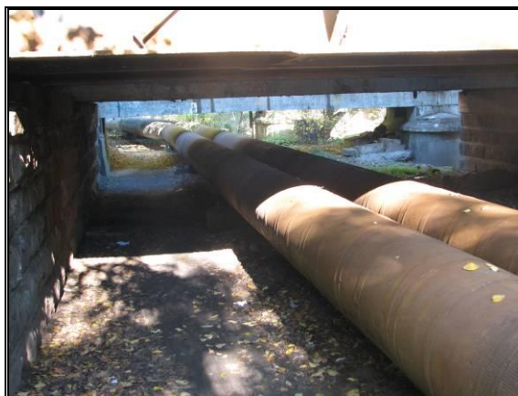
Fot. 5.21 Rury ciepłownicze przebiegające pod obiektem mostowym
