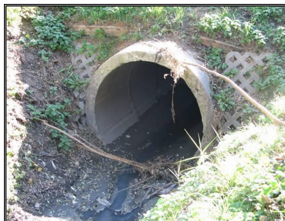
Fot. 3.7 Widok przepustu od strony północnej (wlot)
