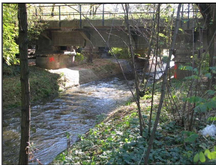
Fot. 5.12 Rzeka Utrata pod mostem kolejowym w Pruszkowie
