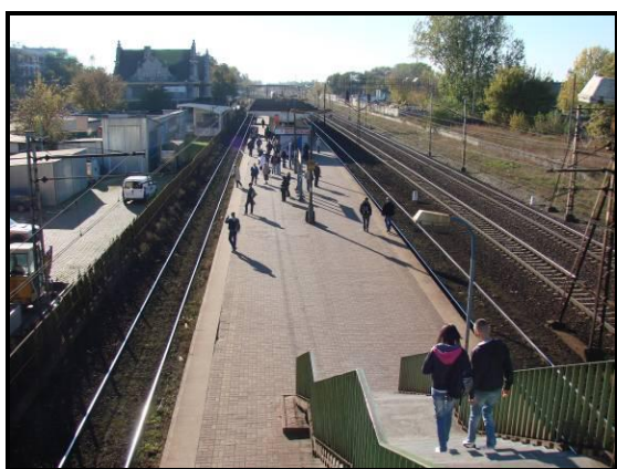
Fot. 5.5 Peron na Stacji Pruszków – widok z kładki dla pieszych
