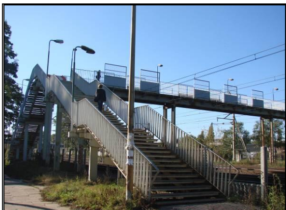
Fot. 5.3 Kładka dla pieszych na torami w km 15+060
