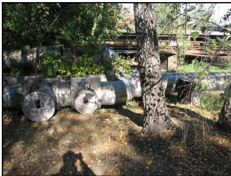
Fot. 5.15 Infrastruktura miejska w dolinie rzeki Utraty w Pruszkowie
