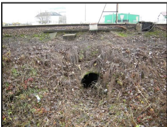
Fot. 3.8 Widok przepustu od strony południowej
