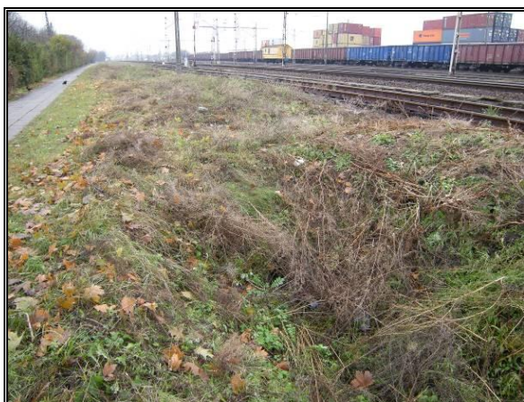
Fot. 3.6 Widok przepustu od strony południowej (wylot dochodzi do studni kanalizacyjnej)
