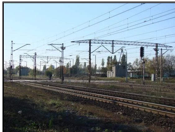
Fot. 5.8 Przejazd drogowy w km 17+313
