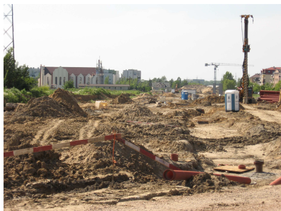
Fotografia 27: Budowa ul. Nowolazurowej
