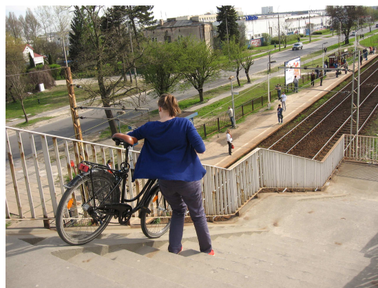
Fotografia 26: Kładka nad torami kolejki WKD
