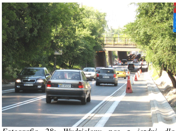
Fotografia 28: Wydzielony pas z jezdni dla rowerów w ciągu ul. Dźwigowej (przejazd pod torami)
