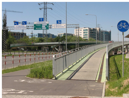
Fotografia 24: Kładka nad ul. Rzymowskiego
