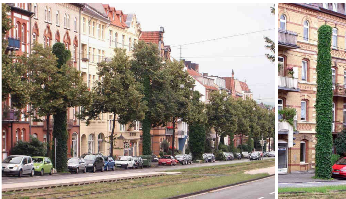
rys. 27 - Przykłady słupów trakcyjnych obrośniętych roślinnością (Kassel, RFN)
