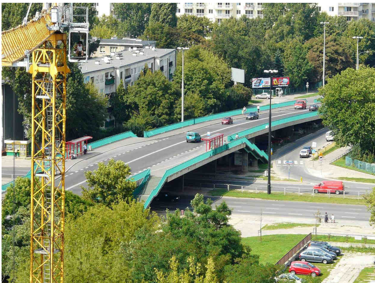
rys. 14 - Wiadukt w ciągu ulicy Saskiej nad Trasą Łazienkowską.
