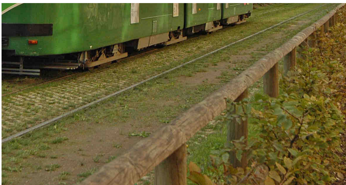
rys. 26 - Przykład torowiska wygradzonego elementami drewnianymi (Graz, Austria)
