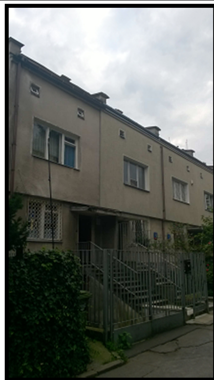
Rys. 9. Lokalizacja punktu pomiarowego Pp4 – ul. Saska 3a
