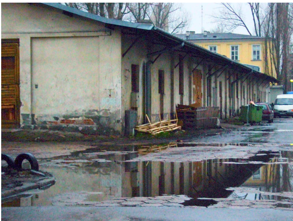
Ul. Szwedzka 2/4 bud 31 (elewacja frontowa) magazyn
