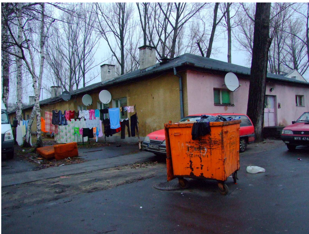
Ul. Szwedzka 2/4 bud 16, budynek mieszkalno usługowy - szwalnia
