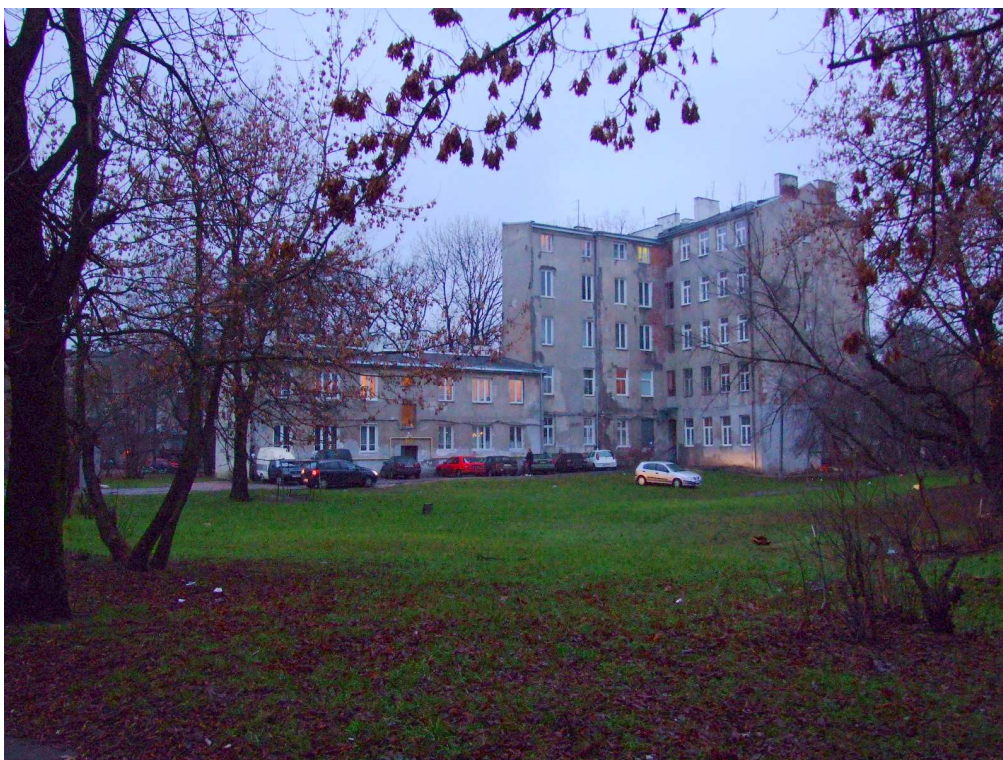
Ul. Stalowa 73, budynek mieszkalny
