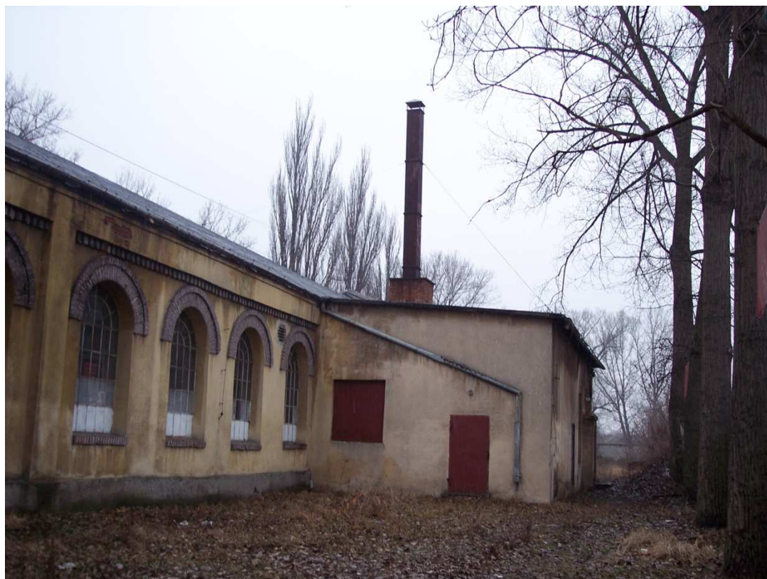
Zdjęcie 2. Budynek produkcyjny dawnej stalowni warszawskiej.
