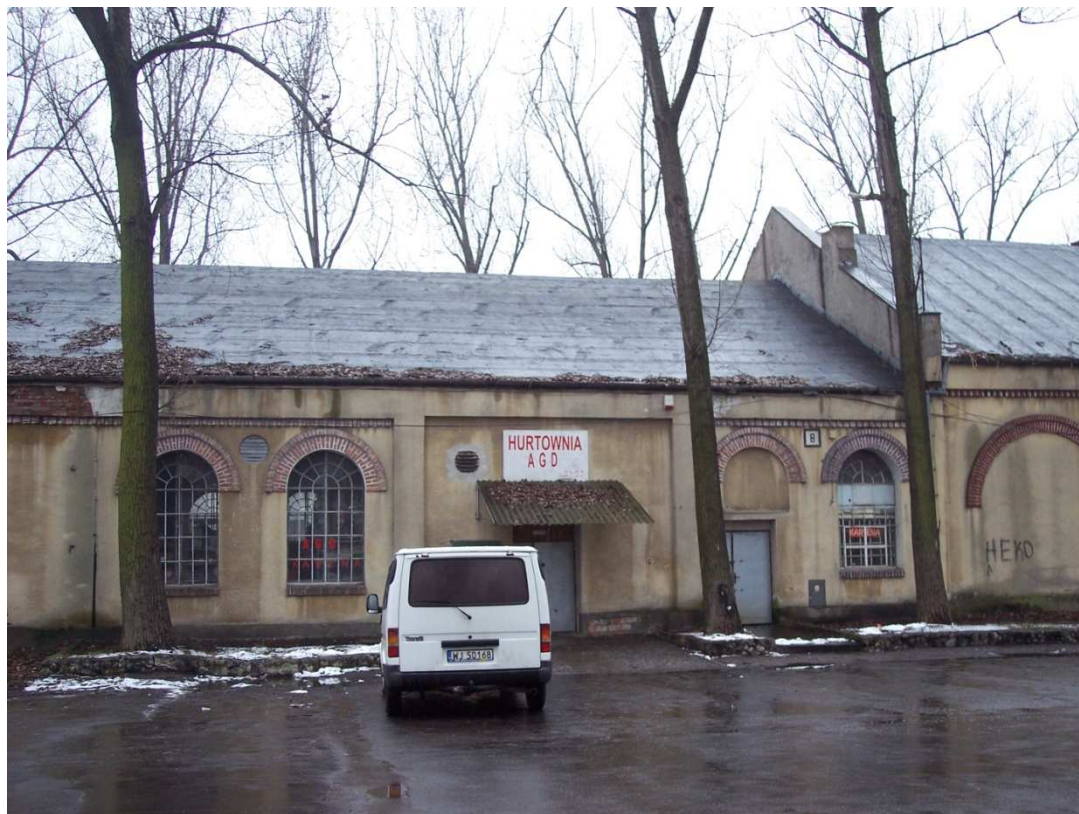
Zdjęcie 1. Budynek produkcyjny dawnej stalowni warszawskiej.
