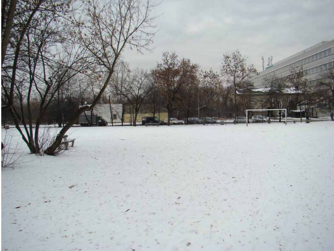
Zdj. 29 Widok od strony ul. Bliskiej na budynek przy ul. Żupniczej 4 i Nowińskiej 8
