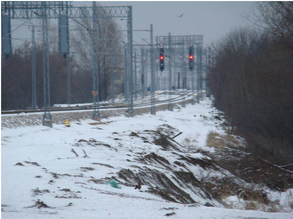
Zdj. 6 Widok z miejsca planowanej ul. Tysiąclecia na nasyp kolejowy w kierunku Dworca Wschodniego
