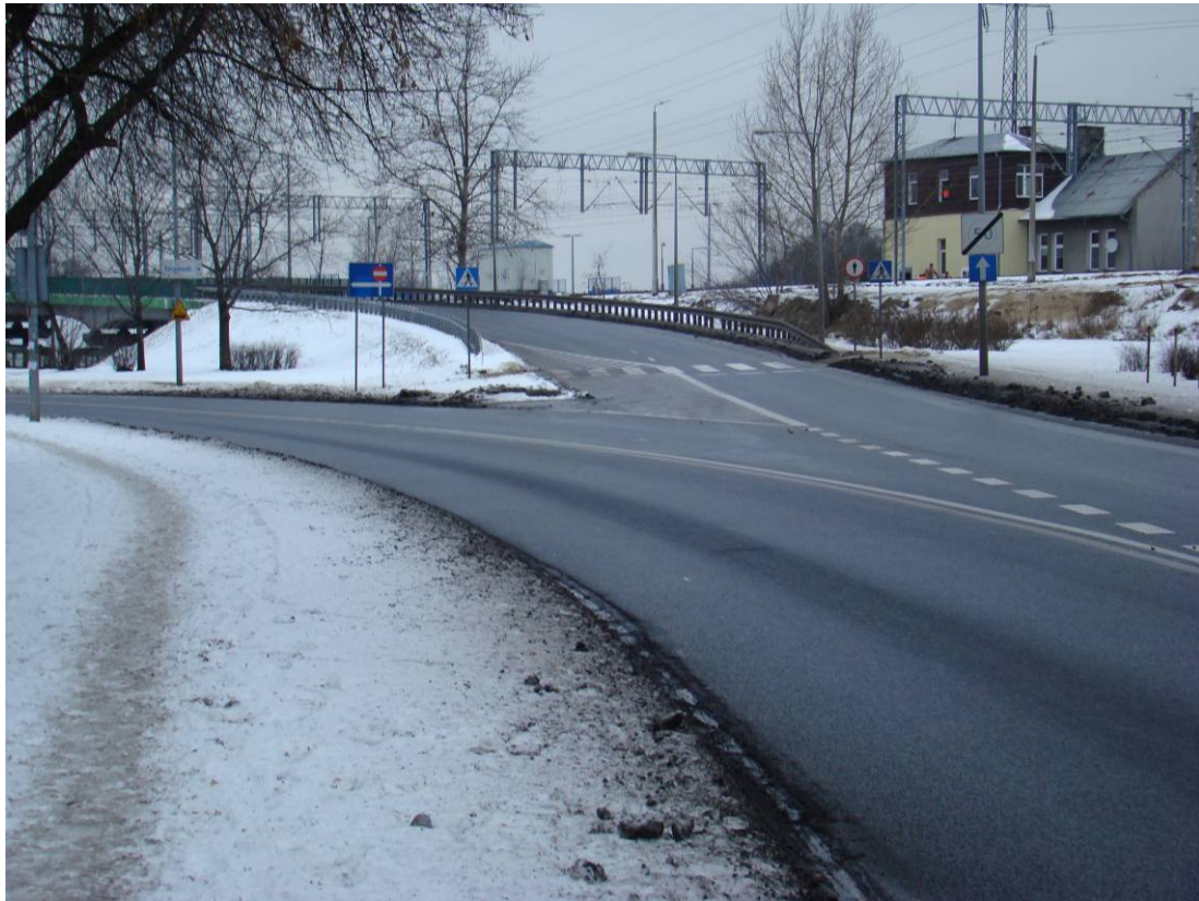
Zdj. 3 Istniejący wiadukt nad ul. 11 Listopada łączący się z ul. Starzyńskiego
