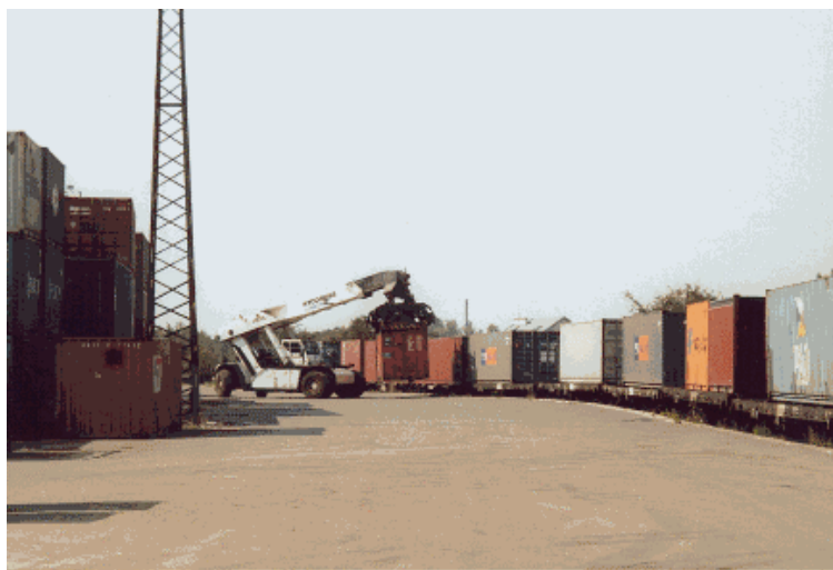
Rys. G.6 – Terminal kontenerowy firmy Polzug, Pruszków
