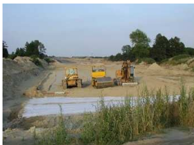
foto. Piotr Sereczyński Faza realizacji inwestycji.
