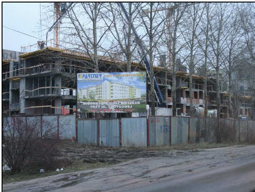
Fot.4 Zabudowa wielorodzinna w budowie po północnej stronie ulicy
