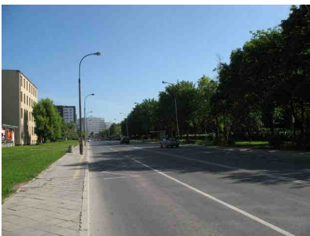
Fot. 7.5. Ulica Postępu, odcinek od ul. Marynarskiej do ul. Cybernetyki – stan istniejący.
