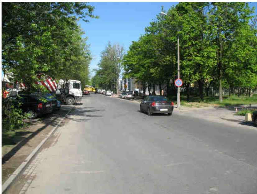
Fot. 7.10. Ulica Domaniewska, na zachód od skrzyżowania z ulicą Postępu
