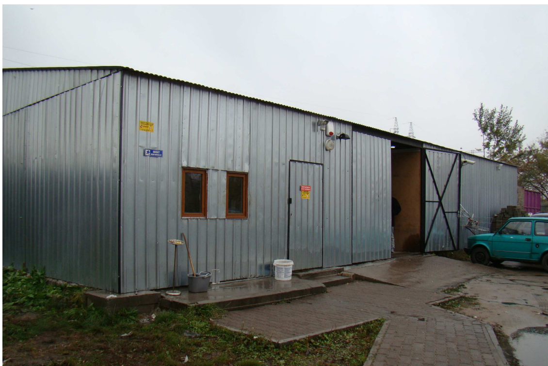
fot.4. okolice ul. 11-ego Listopada i ul. Stalowej działka 2, obręb 41302
