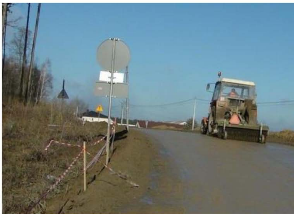
Fot. 6-2 Czyszczenie dróg dojazdowych
