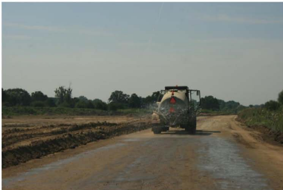
Fot. 6-1 Zraszanie dróg dojazdowych w celu ograniczenia pylenia
