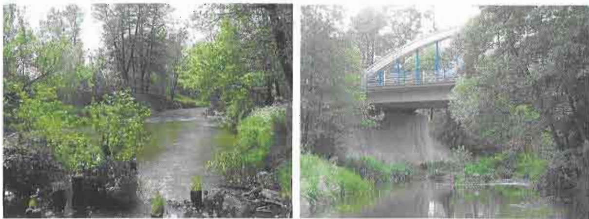
Fot. 5.5 Widok spod mostu drogowego w ciągu drogi nr 17, w dół rzeki Świder
