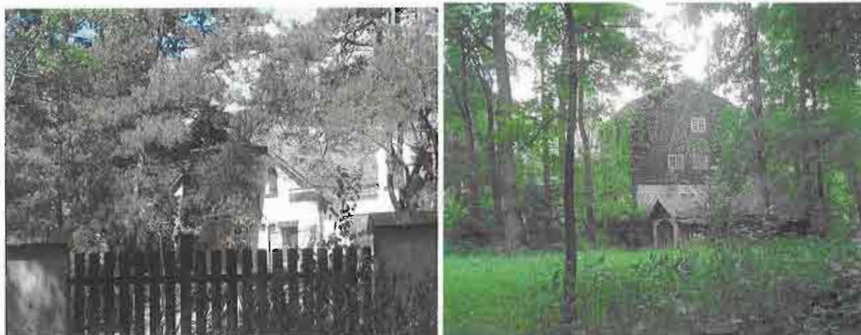
Fot.8.6 Budynek jednorodzinny leżący w sąsiedztwie przebiegu wariantu 1c, km 10+700
