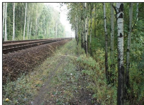
Fotografia 4-2 Miejsce przebiegu drogi na przecięciu z linią kolejową nr 21
