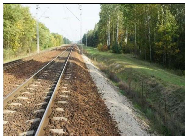
Fotografia 4-6 Miejsce przebiegu drogi na przecięciu z linią kolejową nr 2
