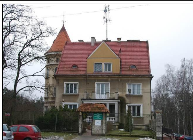
Fotografia 4-78 Wpisany do rejestru zabytków budynek szpitala MSWiA
