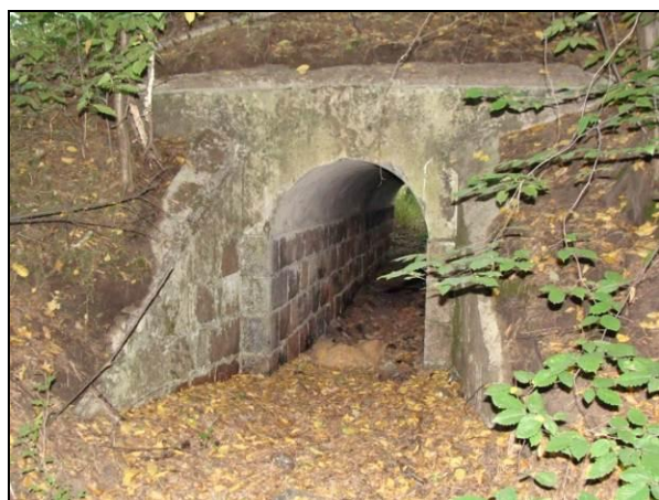
Fotografia 4-77 Przepust będący pozostałością po linii wąskotorowej
