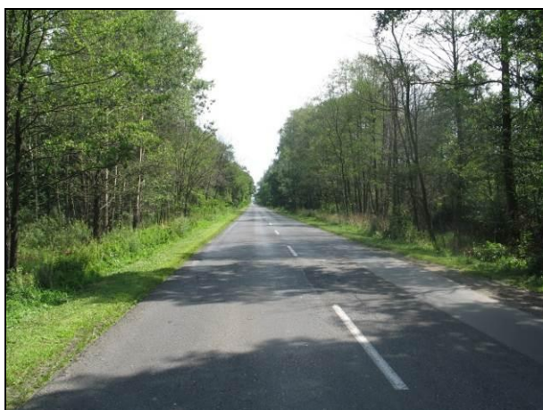
Fotografia 4-7 Droga wojewódzka nr 637 w rejonie przyszłego węzła Rembertów
