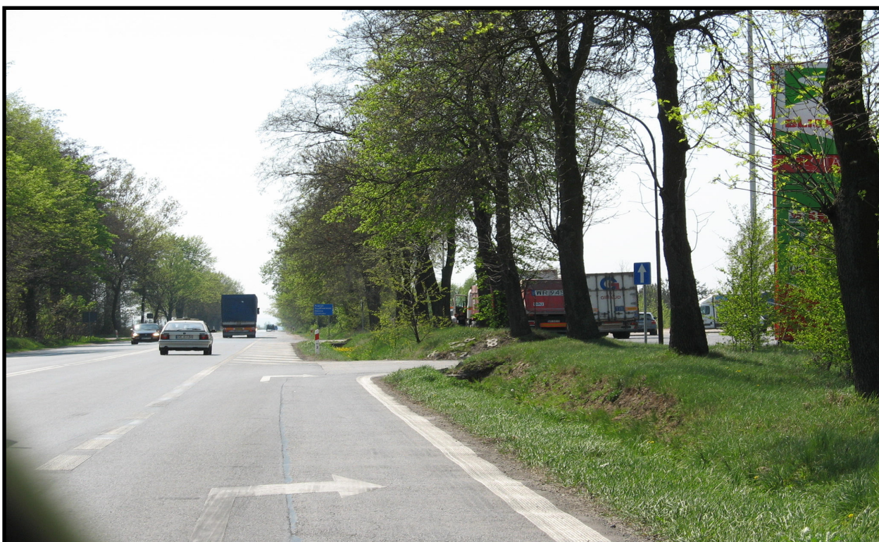
il. 4 – m. Młodocin – droga krajowa nr 7 (widok w kierunku Krakowa)
