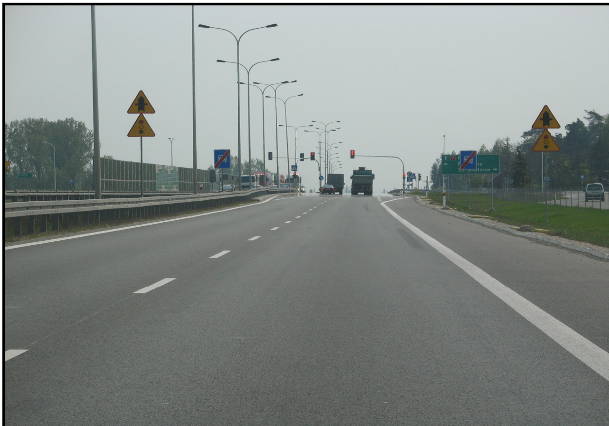
il. 1 - m. Kępiny – droga S7 (jezdnia w kierunku Krakowa)
