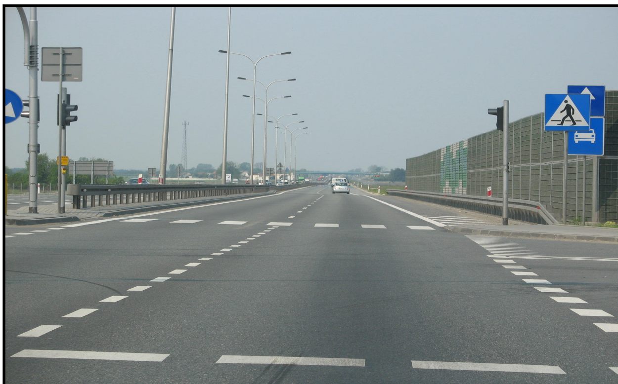
il. 2 – m. Kępiny – droga S7 (jezdnia w kierunku Warszawy)
