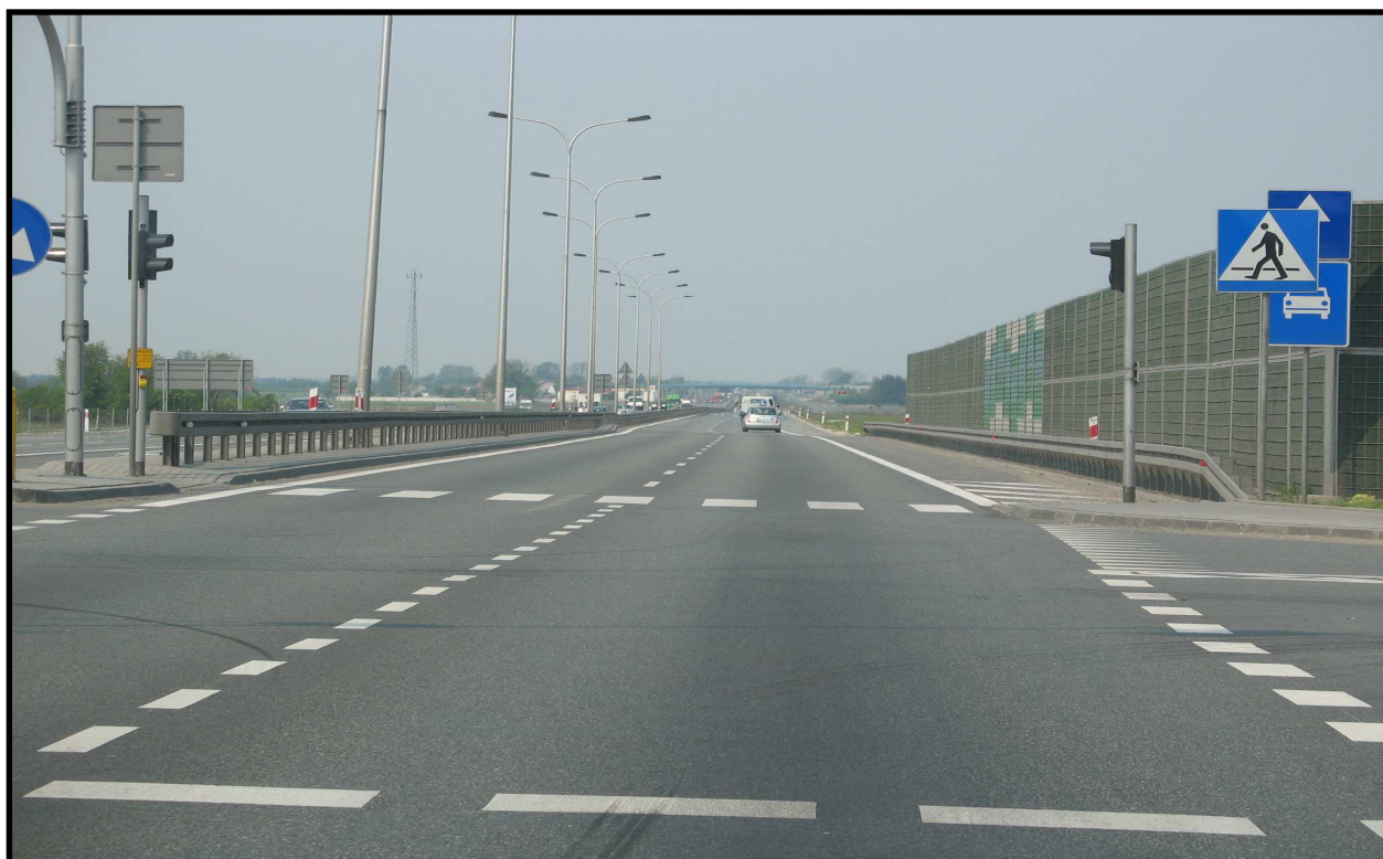
il. 2 – m. Kępiny – droga S7 (jezdnia w kierunku Warszawy)
