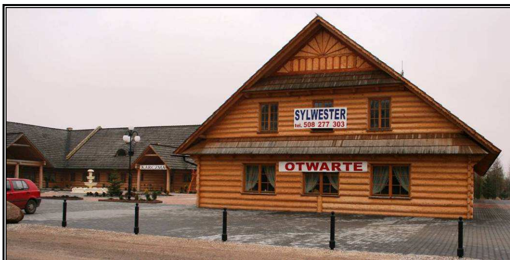
Zdjęcie 33. Korekta węzła „Radom Południe” pozwoli uniknąć rozbiórki tego nowego obiektu.
