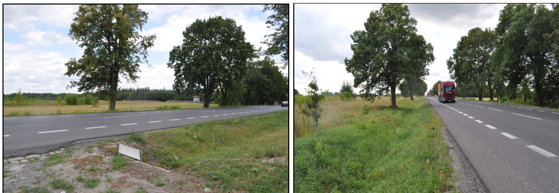
Zdjęcie 14. Zagospodarowanie na terenach przeznaczonych pod węzeł „Młodocin” – rok 2013.
