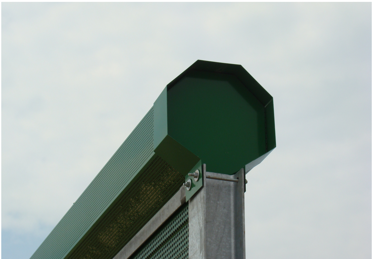
Fotografia 2 Dyfraktor (reduktor oktagonalny)
