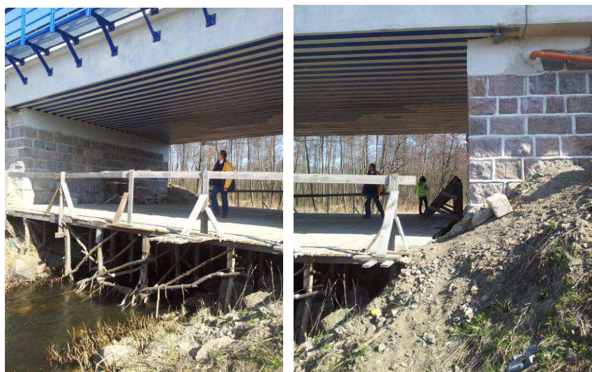
Fot. 1 Sposób zabezpieczenia koryta rzek przed zanieczyszczeniami w fazie budowy obiektu mostowego - tymczasowy podest ze szczelnie ułożonych desek na całej szerokości obiektu mostowego
