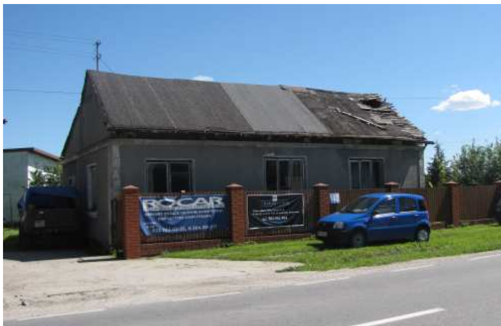
Fot. 32 Budynek mieszkalny przeznaczony do rozbiórki zlokalizowany w miejscowości Ciemne, w km 11+870, po lewej stronie projektowanej drogi ekspresowej S-8
