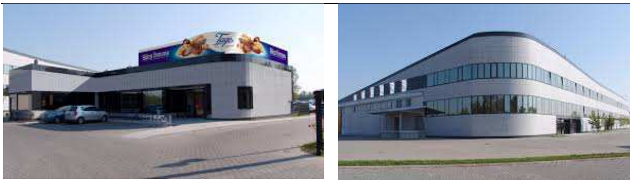
Fot. 29 Zakład produkcyjny TAGO zlokalizowany w miejscowości Ciemne, w km ok. 0+650 po prawej stronie, na wysokości km 11+500 projektowanej drogi S-8
