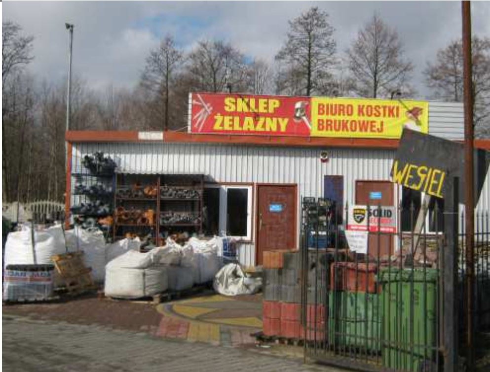
Fot. 35 Budynek przeznaczony do rozbiórki zlokalizowany w miejscowości Ciemne, po lewej stronie, na wysokości km 7+350 projektowanej drogi S-8
