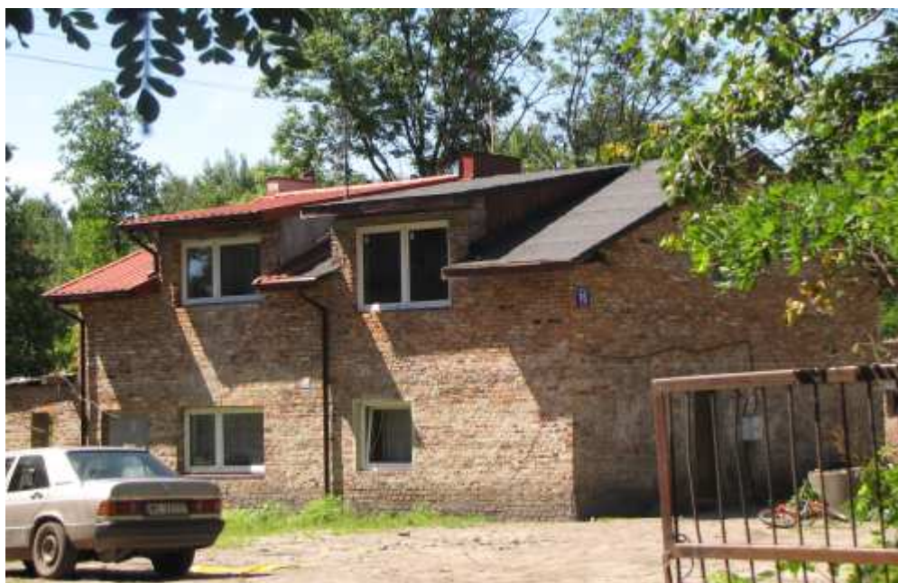
Fot. 30 Budynek mieszkalny przeznaczony do rozbiórki zlokalizowany w miejscowości Nadma, w km 9+915, po lewej stronie projektowanej drogi ekspresowej S-8
