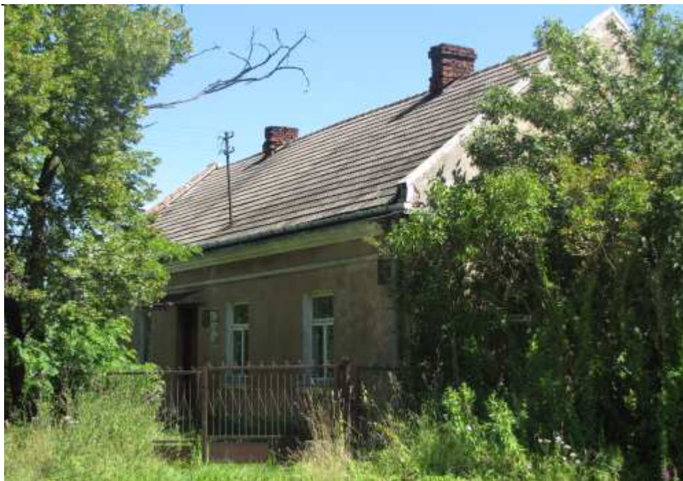
Fot. 33 Budynek mieszkalny przeznaczony do rozbiórki zlokalizowany w miejscowości Ciemne, w km 12+100, po lewej stronie projektowanej drogi ekspresowej S-8
