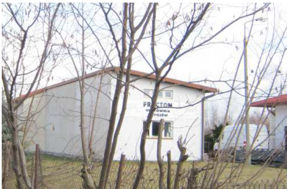
Fot. 28 Hurtownia napojów zlokalizowana w miejscowości Ciemne, w km ok. 0+080 po prawej stronie drogi wojewódzkiej nr 635 przeznaczonej do przebudowy w ramach planowanego przedsięwzięcia
