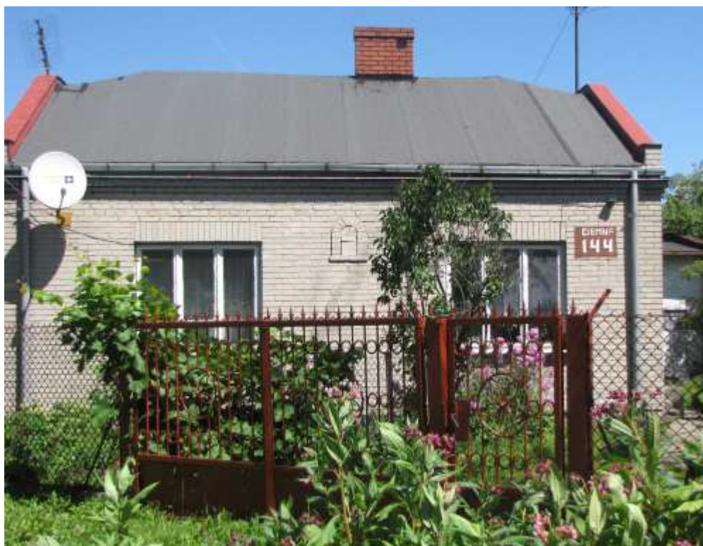
Fot. 34 Budynek mieszkalny przeznaczony do rozbiórki zlokalizowany w miejscowości Ciemne, w km 12+135, po lewej stronie projektowanej drogi ekspresowej S-8
