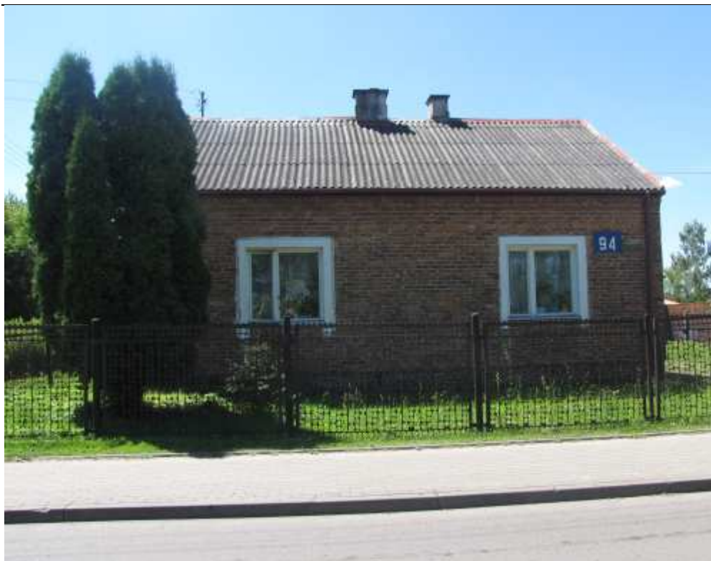
Fot. 31 Budynek mieszkalny przeznaczony do rozbiórki zlokalizowany w miejscowości Ciemne, w km 11+220, po lewej stronie projektowanej drogi ekspresowej S-8
