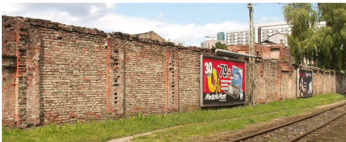
Widok ogrodzenia od strony ulicy Prostej
