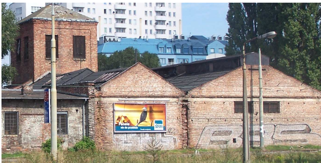
Widok budynku od strony południowej (od ulicy Prostej)
