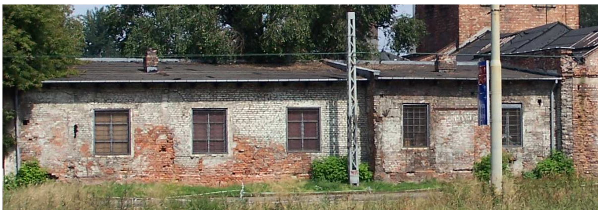
Widok południowej ściany budynku (od strony ulicy Prostej)
