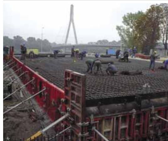
Fot. 3. Zbrojenie i szalowanie płyty stropowej
