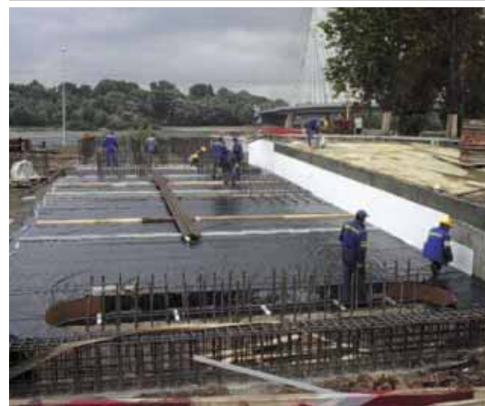
Fot. 2. Szalowanie spodu i boków płyty stropowej
