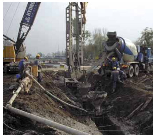
Fot. 1. Betonowanie ściany szczelinowej
