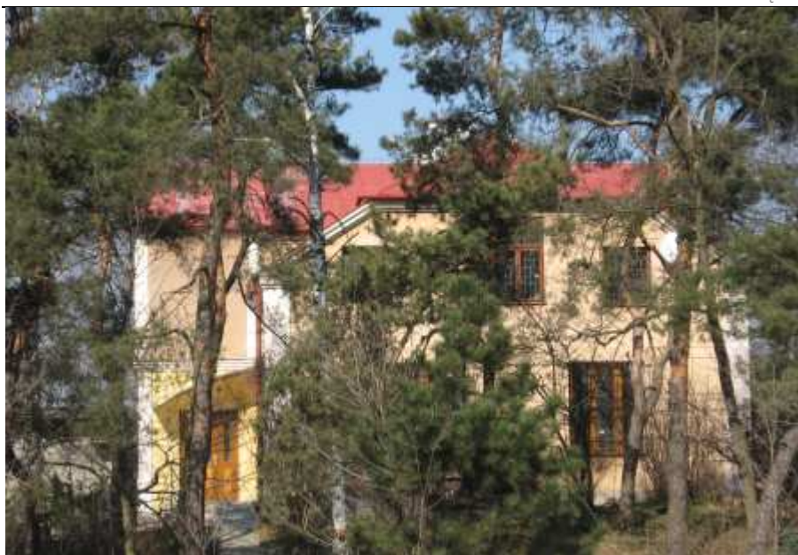
Fot. 2 Budynek przy ul. Marsa 61
