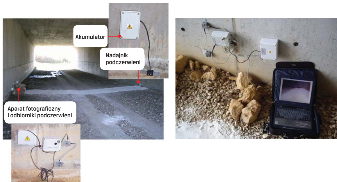
Rysunek 4.19. Instalacja systemu fotograficznego na przejściu zintegrowanym pod drogą oraz pobieranie danych z aparatu cyfrowego i przenoszenie ich na komputer przenośny. Zdjęcia: TEG-UAM.
