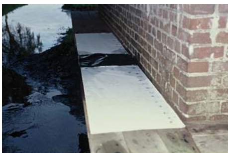
Rysunek 4.14. Koryta wypełnione farbą umieszczone na platformie, co ma ułatwić przechodzenie zwierzętom przez przepust. Zdjęcie: Hans Bekker.
