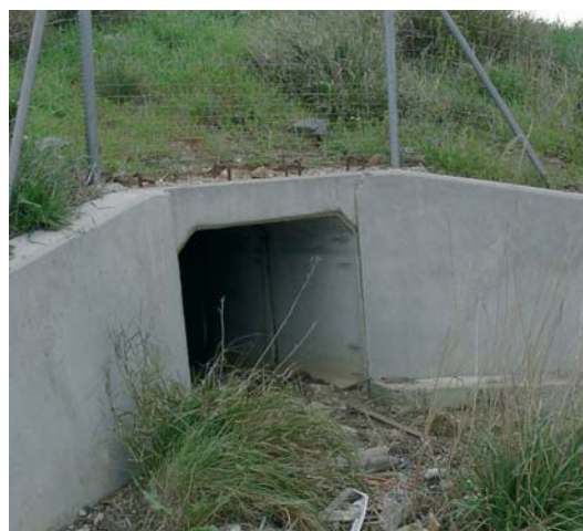
Rysunek 4.26. Dwa aspekty kontrolowane na przejściach dla zwierząt: utrzymanie posadzonej roślinności (po lewej) i gromadzenie się gruzu na wejściach do przejść dla małych kręgowców (po prawej). W drugim przypadku chodzi o odpady pochodzące z dróg, ponieważ system drenażu z nawierzchni poprowadzony został do środka konstrukcji przeznaczonych na przejścia dla zwierząt. Zdjęcia: TEG-UAM, Minuartia.
