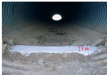
Rysunek 4.13. Rozmieszczenie pasa zawierającego marmur syntetyczny na przepuszczeniu z blachy falistej. Zdjęcia: TEG-UAM.
