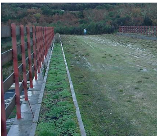
Rysunek 4.26. Dwa aspekty kontrolowane na przejściach dla zwierząt: utrzymanie posadzonej roślinności (po lewej) i gromadzenie się gruzu na wejściach do przejść dla małych kręgowców (po prawej). W drugim przypadku chodzi o odpady pochodzące z dróg, ponieważ system drenażu z nawierzchni poprowadzony został do środka konstrukcji przeznaczonych na przejścia dla zwierząt. Zdjęcia: TEG-UAM, Minuartia.
