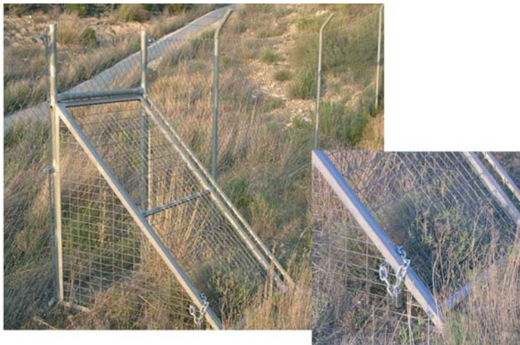
Rysunek 4.27. Urządzenie odprowadzające zamykane na kłódkę uniemożliwia ewentualne wykorzystanie go przez zwierzęta. Zdjęcia: TEG-UAM.
