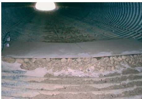
Rysunek 4.13. Rozmieszczenie pasa zawierającego marmur syntetyczny na przepuszczeniu z blachy falistej. Zdjęcia: TEG-UAM.
