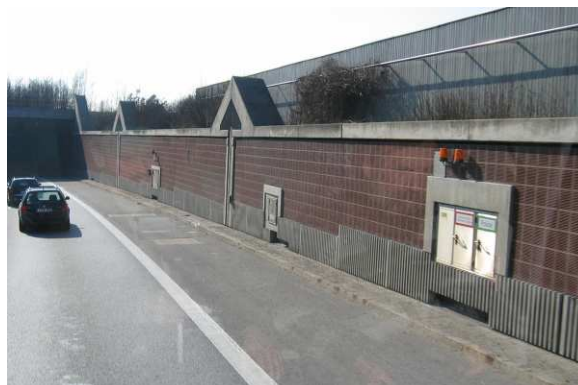
Fot. 7.2. Wlot do tunelu (Niemcy)
