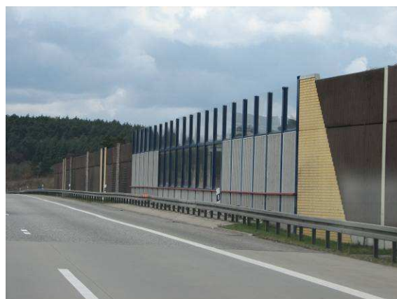
Fot. 7.11. Przykład zastosowania ekranu akustycznego na wiadukcie (Niemcy)
