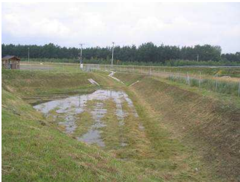
Fot. Z5.3. Zbiornik retencyjno-infiltracyjny, ziemny, otwarty (Autostrada A2, odcinek Konin-Koło)
