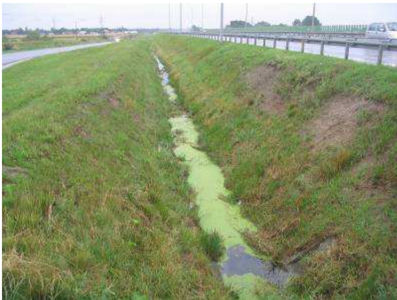
Fot. Z5.1. Rów trawiasty, trapezowy (Autostrada A2, odcinek Września-Konin)
