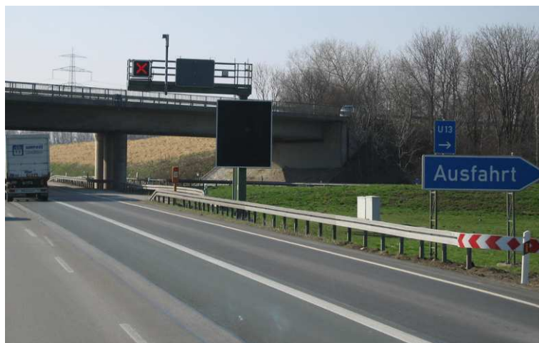
Fot. 7.5. Przykład sterowania ruchem na autostradzie z wykorzystaniem pasa awaryjnego (Niemcy)
