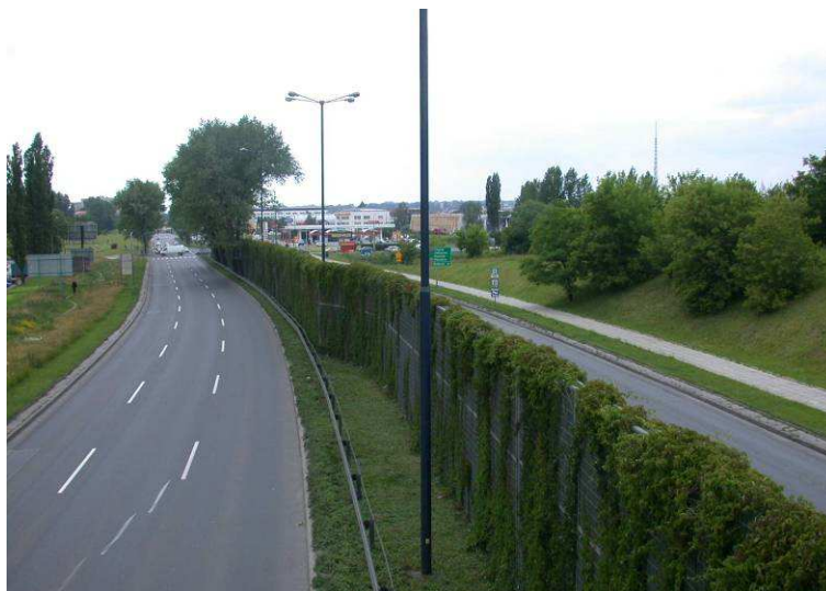
Fot. 7.12. Przykład wału ziemnego (po lewej stronie drogi) oraz ekranu akustycznego w postaci ściany w pasie dzielącym (Polska)
