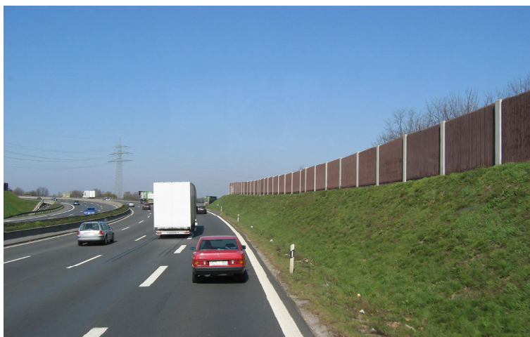
Fot. 7.13. Przykład kombinacji ekranu ziemnego z ekranem akustycznym (Niemcy)
