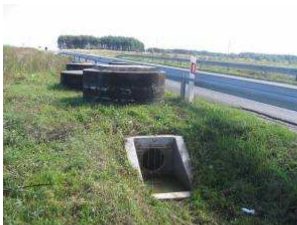
Fot. Z5.7. Separator (na pierwszym planie) zintegrowany z osadnikiem
