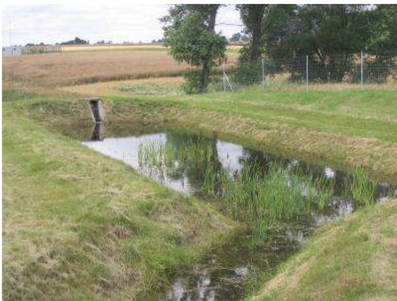
Fot. Z5.4. Zbiornik retencyjno-infiltracyjny (Autostrada A2, odcinek Września – Konin)
