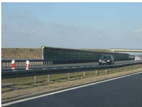
Fot. 7.10. Przykład typowego zastosowania ekranu akustycznego na autostradzie A4 (Polska)
