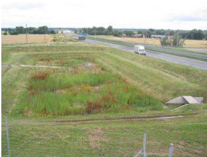
Fot. Z5.2. Zbiornik retencyjno-infiltracyjny, (Autostrada A2, odcinek Września-Konin)
