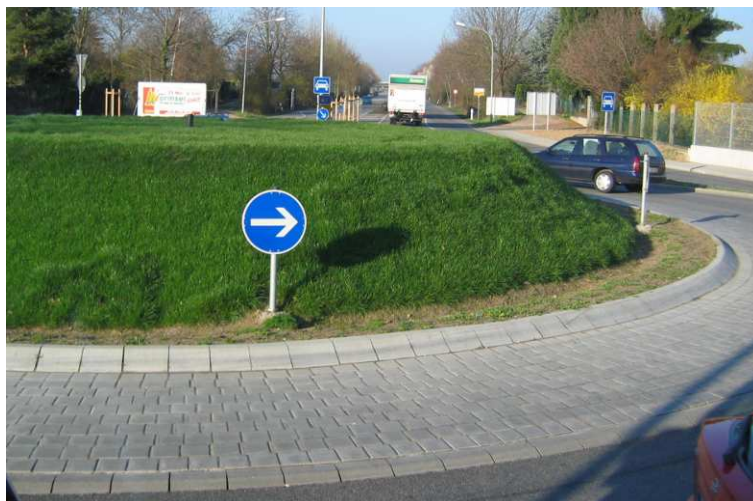
Fot. 7.9. Przykład ograniczenia prędkości i jednoczesnego utrzymania płynności ruchu poprzez zastosowanie ronda (Holandia)
