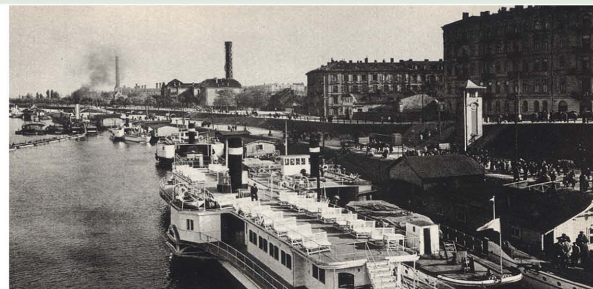
REJON MOSTU PONIATOWSKIEGO
